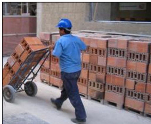
Figura 53. Transporte de Bloque en cada piso de las torres
