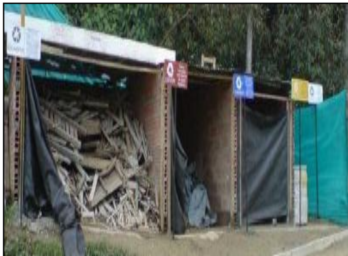
Figura 46. Adecuado Manejo de escombros
