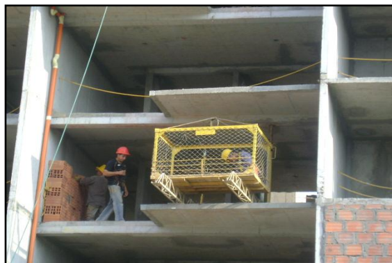
Figura 13. Descargue de Material Asumido por el contratista
