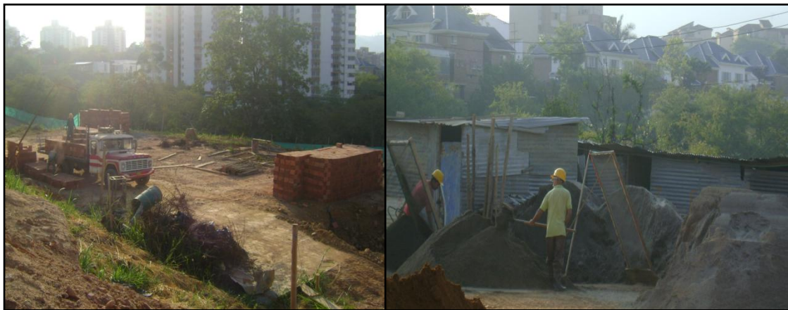
Figura 50. Descargue de Ladrillo
