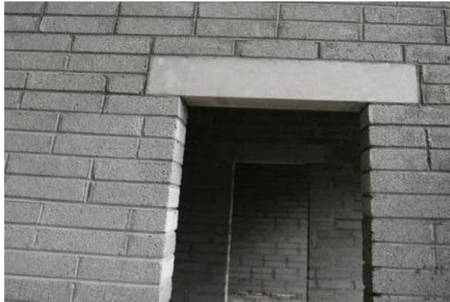
Figura 36. Ejemplo de dintel en obra civil
