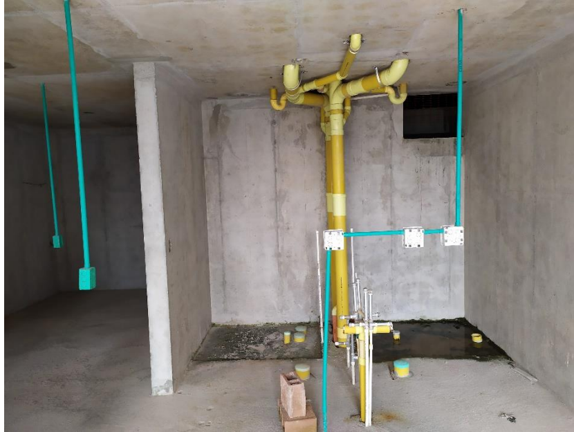
Figura 11. Prolongación de tubería (Foto tomada en la práctica empresarial).
