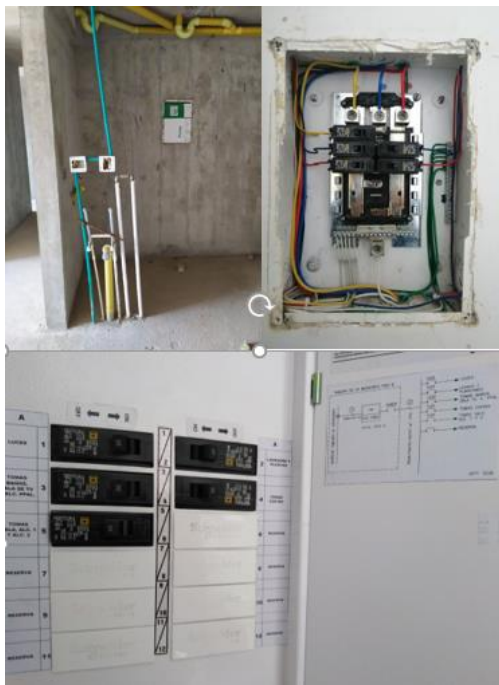
Figura 10. Pasos del proceso de instalación de tableros de distribución e interruptores automáticos (Foto tomada en la práctica empresarial).
