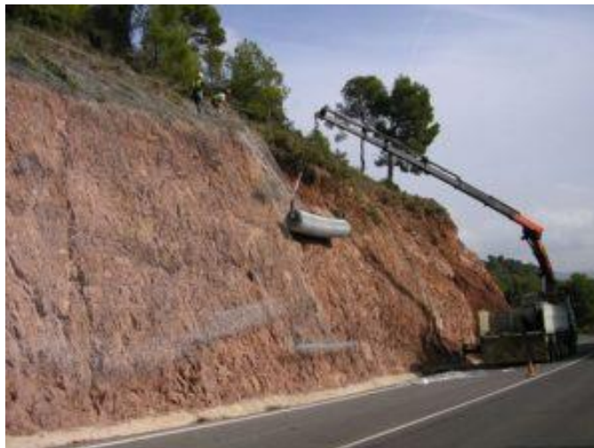
Figura 41. Ejemplo de talud
