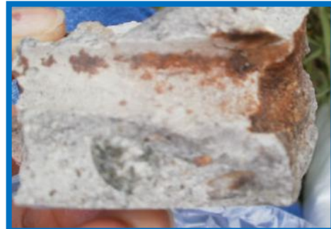
c) Probeta de concreto reforzado tipo A0
