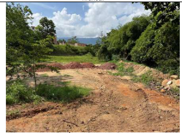
Fotografía 4. Área objeto de relleno con RCD
