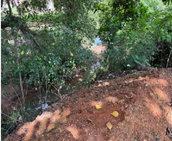
Fotografía 5: Relleno hasta el borde de fuente hídrica
