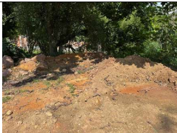
Fotografía 3. Área objeto de relleno con RCD
