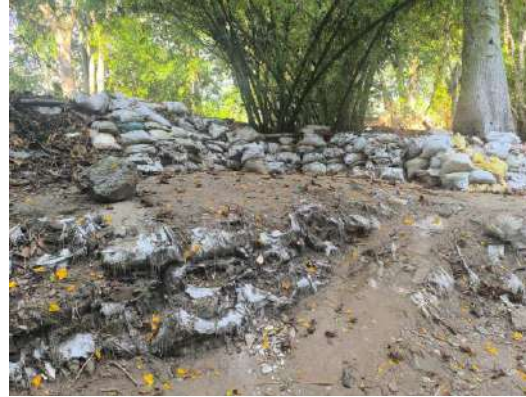
Fotografía 6. Disposición de RCD
