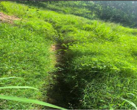
Fotografía 9: Zanga conducción de aguas lluvias
