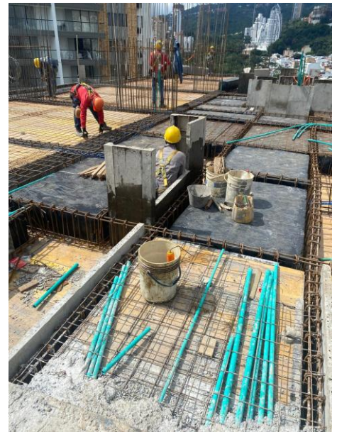
Ilustración 12 Armado de Elementos Estructurales Piso 17
