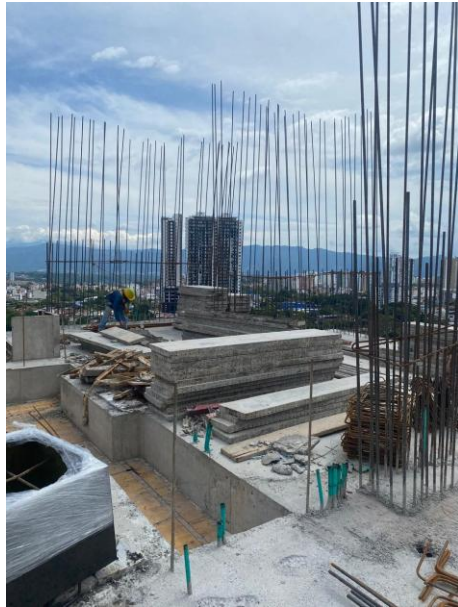
Ilustración 11 Armado de Elementos Estructurales Piso 16
