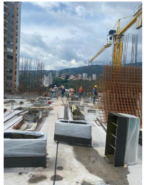
Ilustración 10 Armado de Elementos Estructurales Piso 16
