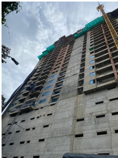
Ilustración 13 Fachada frontal Torre 2 Flora Club House
