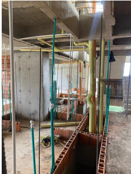
Ilustración 7 Instalación Hidráulica en conjunto con Mampostería Apto 14-01
