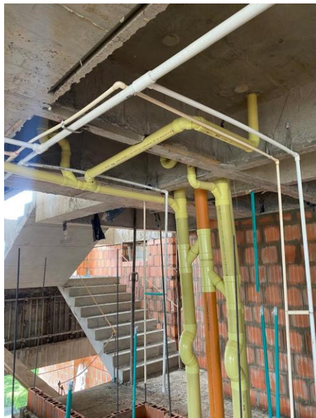
Ilustración 8 Instalación Sanitaria en conjunto con Mampostería Apto 14-03
