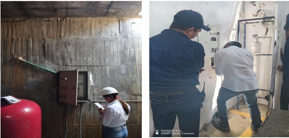
Figura 1. Inspección al sistema eléctrico
