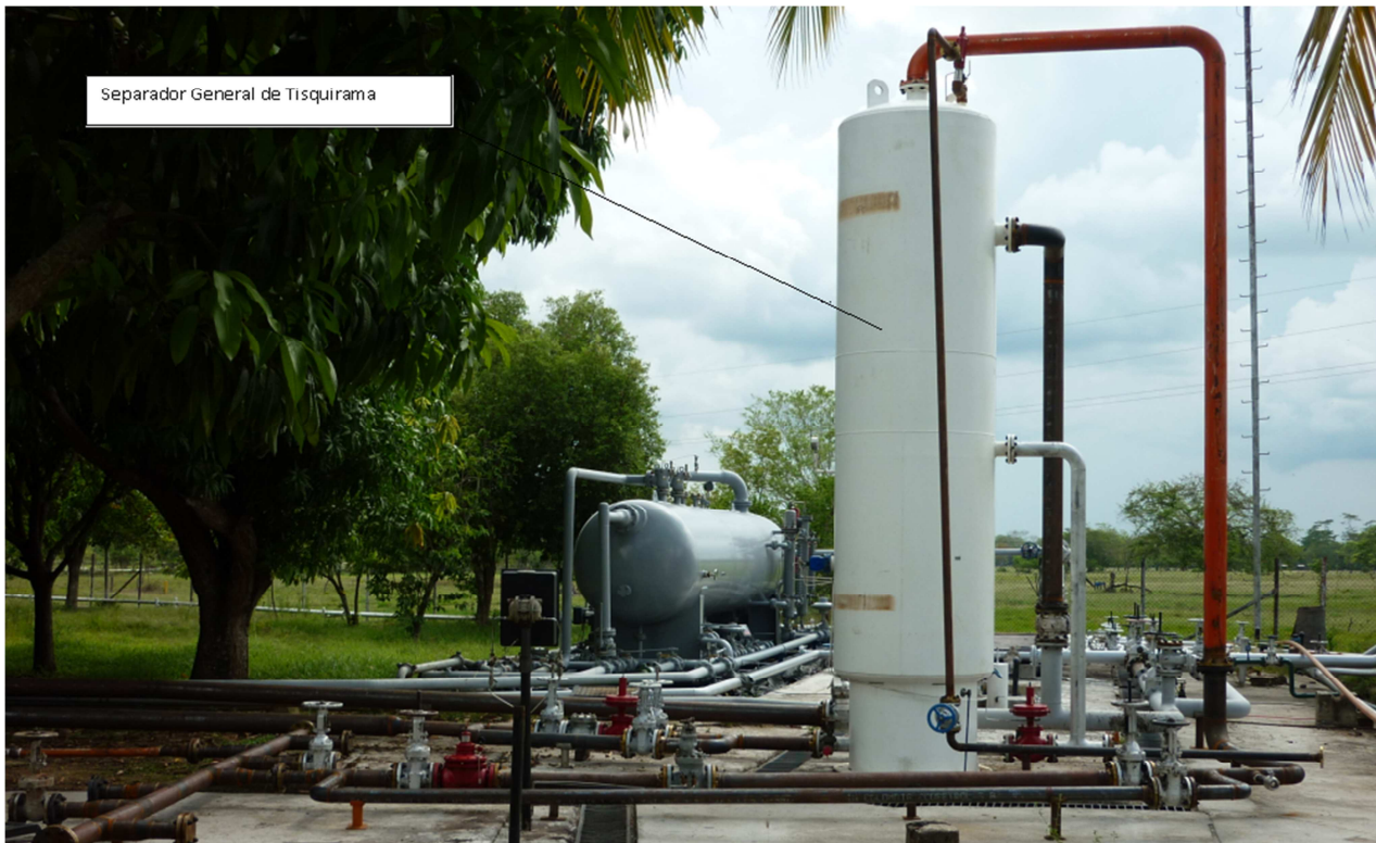
Figura 26. Separador General Estación Tisquirama
