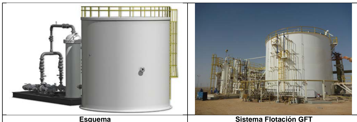
Figura 35. Esquema alternativa 3 - Flotación GFT
