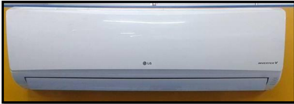
Figura 33. Aire acondicionado tipo mini Split
