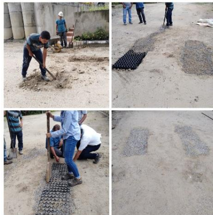
Figura 18. Instalación de mallas sector Pradosol (Estacionamiento).
