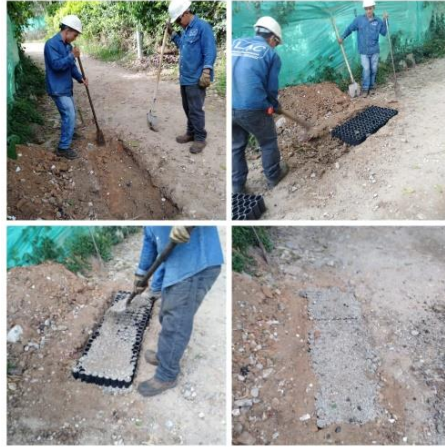
Figura 17. Instalación de mallas sector Ruitoque Bajo (Vía terciaria).
