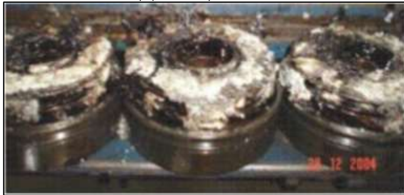
Figura 6. Acumulación de arena en equipos de superficie.
