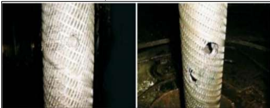
Figura 7. Erosión de la tubería causado por arenamiento.
