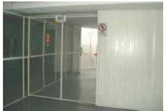
Foto 33. Entrada planta de producción.
