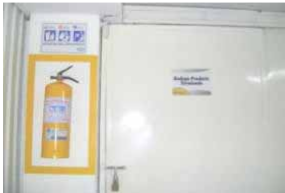
Foto 34. Bodega de producto terminado.
