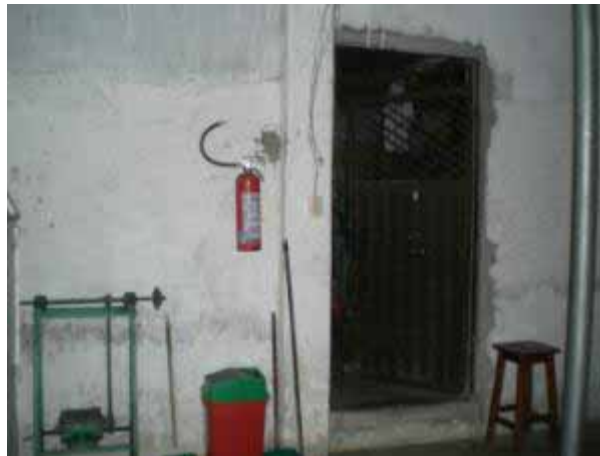
Foto 19. Puerta cuarto de mantenimiento.
