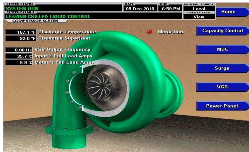
Figura 13. Pantalla del compresor.
