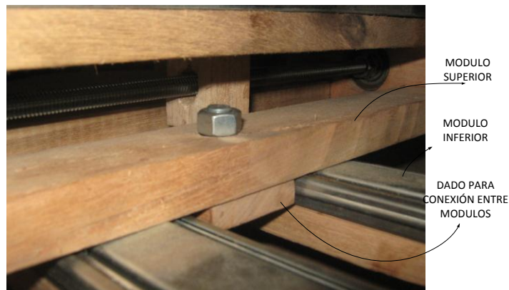
Figura 36. Conexión entre los módulos de madera.
