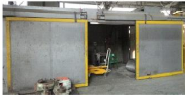
CABINA DE LAVADO
