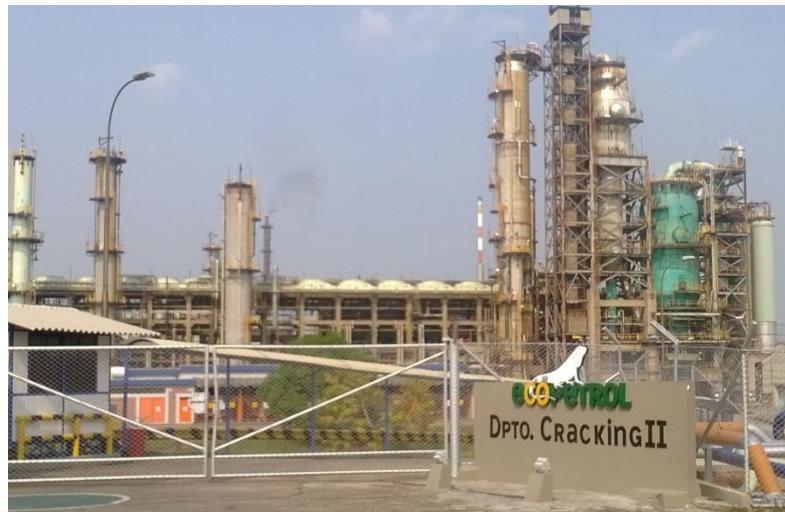
Figura 4. Planta de Proceso – Cracking II
