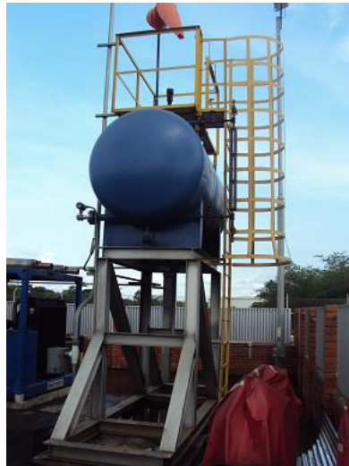
Figura 19. Tanque de almacenamiento de agua
