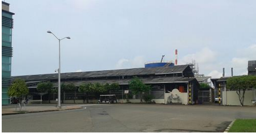
Figura 7. Talleres de Mecánica y Metalistería – Gerencia Refinería Barrancabermeja
