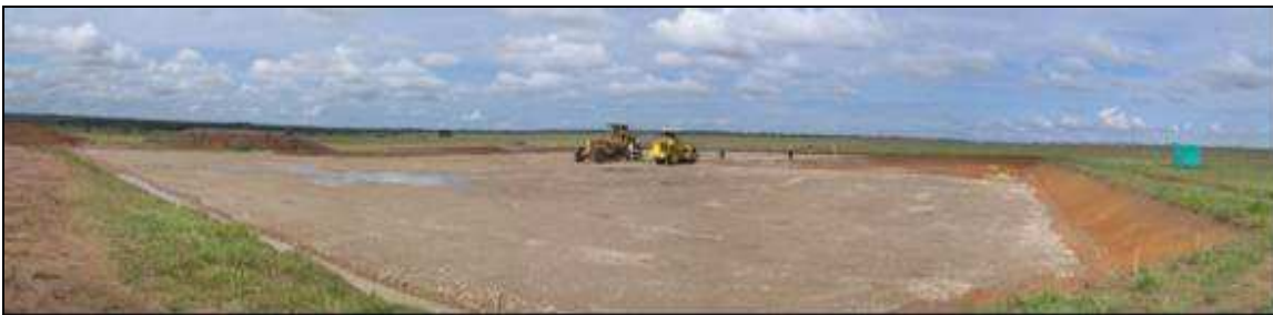
Figura 5 Panorámica de una locación terminada.
