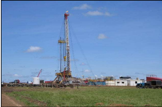
Figura 6 Equipo utilizado para la perforación de pozos. Fuente: El autor
