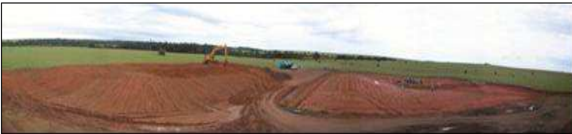
Figura 4 Panorámica de la construcción de una locación
