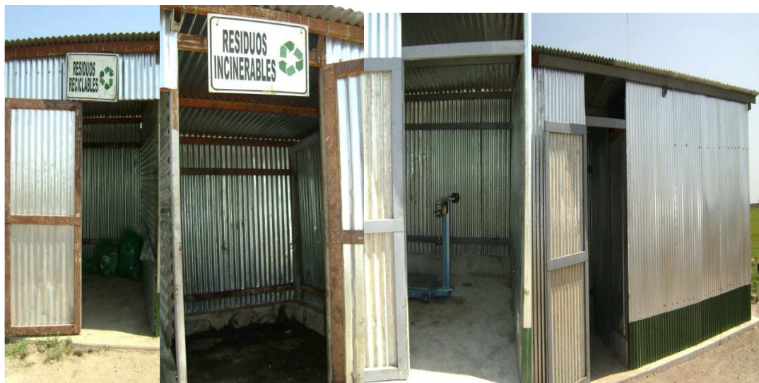
Figura 20 Compartimientos centro de acopio de residuos sólidos. Fuente: El autor.
