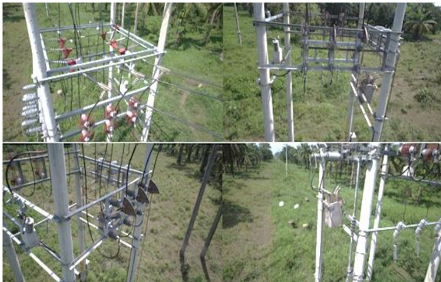
Figura 5. Pórtico enlace Garzas
