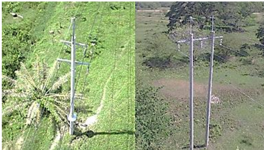
Figura 4. Estructura de suspensión en S y SH.
