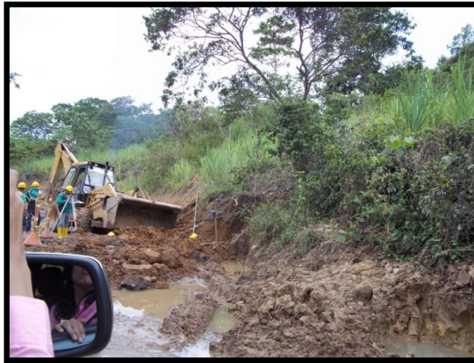
Ilustración 8. Depósito de Ladera.
