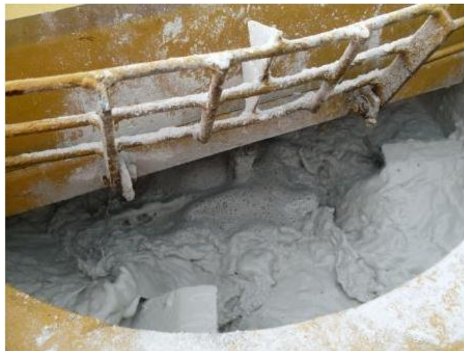
Figura 31. Inyección de elementos químicos
