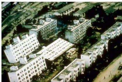
Figura 1. Niigata, Japón 16 de junio 1964 04:01, Magnitud 7.5, colapso de edificaciones por licuefacción
