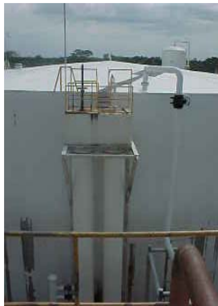
Foto 11. Anillos instalados en los FWKO's
