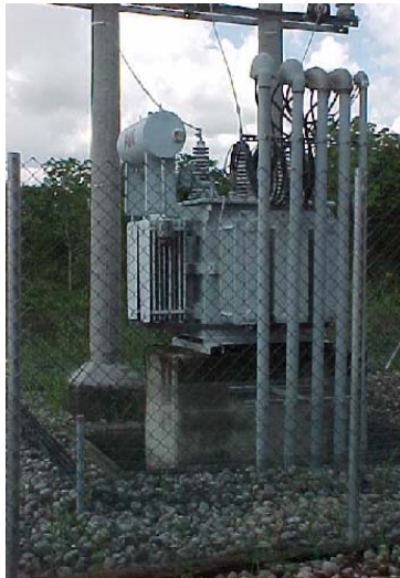
Foto 17. Transformador reductor
