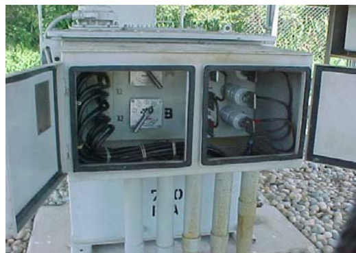
Foto 16. Transformador elevador
