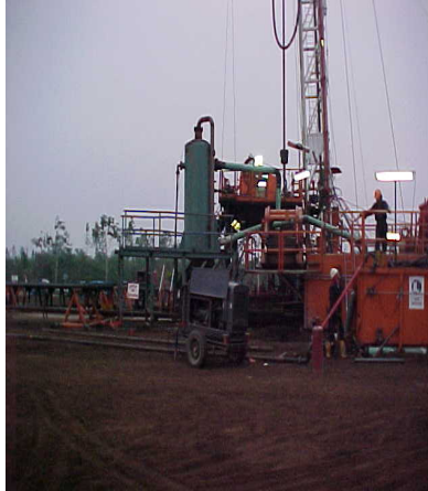
Foto 29. Torre para Servicio a Pozo
