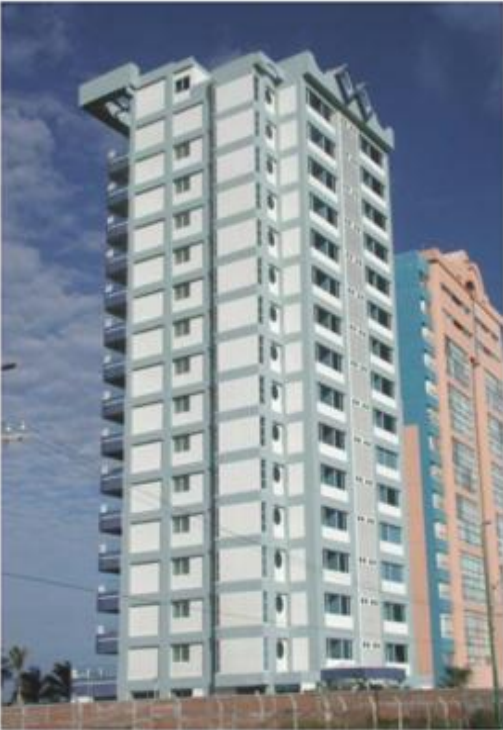
Figura 1. Edificio Instrumentado OASIS
