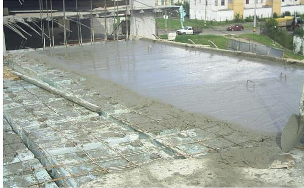
*Figura 4.* Junta de construcción mal construida.
