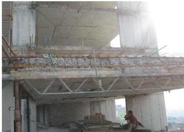
*Figura 5.* Junta de construcción mal construida
