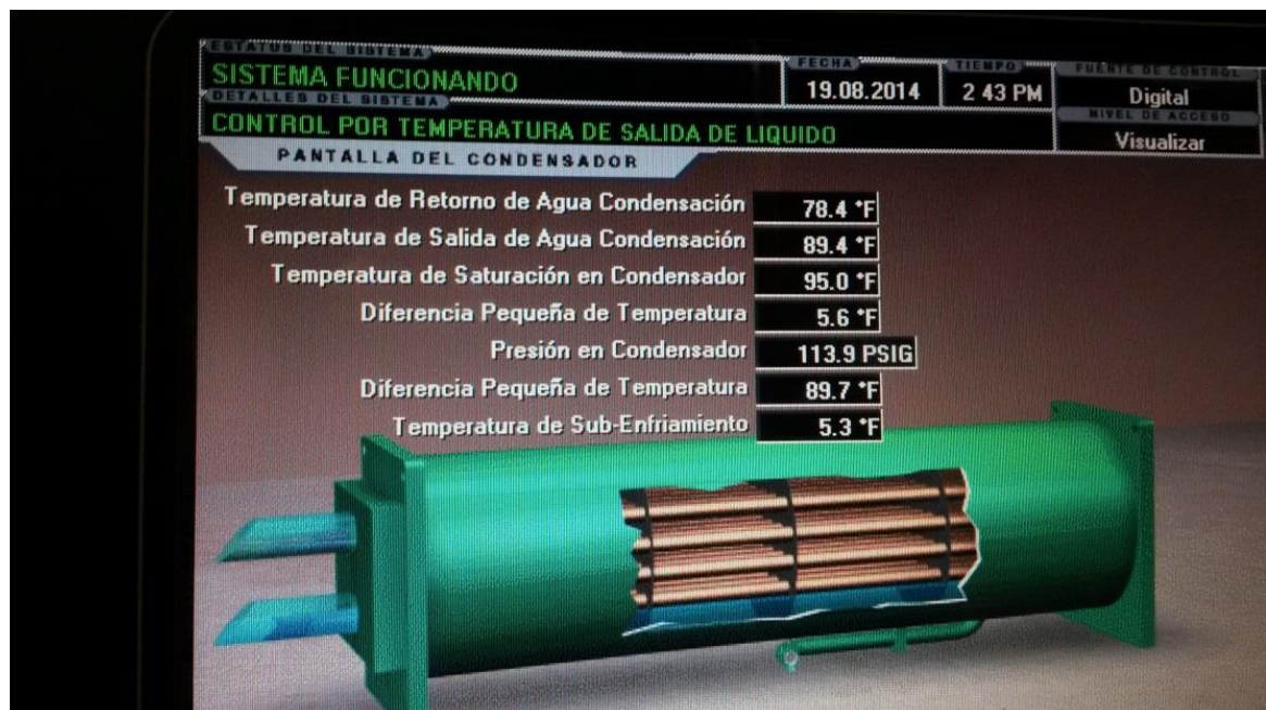
Figura 37. Pantalla de condensador en el Chiller
