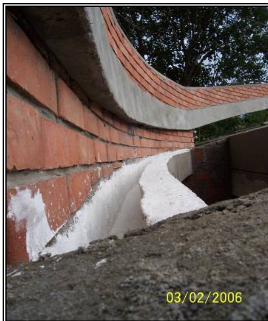
Figura 54: Viga canal de la planta piloto
