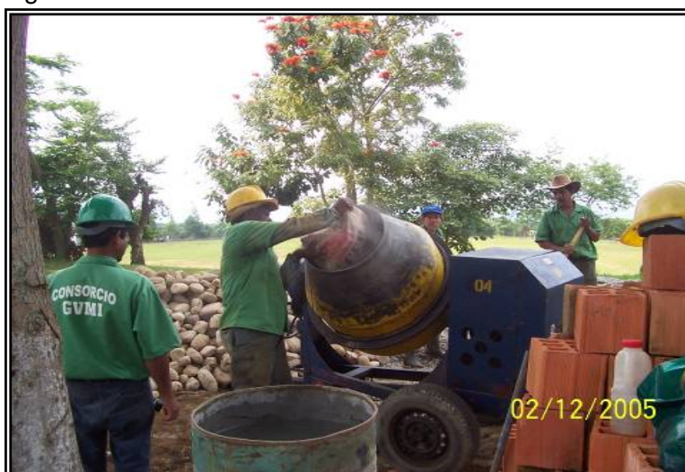
Figura 23. Concreto utilizando mezcladora
