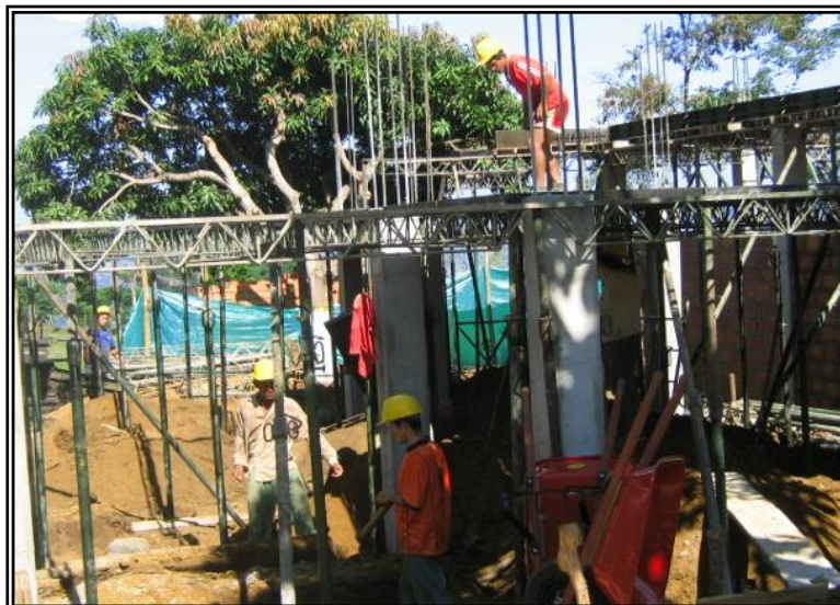
Figura 20. Formaletas necesarias para fundida
