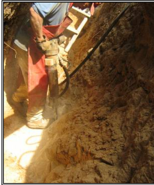
Figura 56: Excavación en roca
