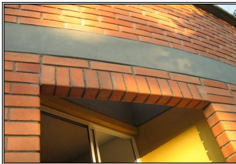
Figura 53: Dinteles en ladrillo a la vista
