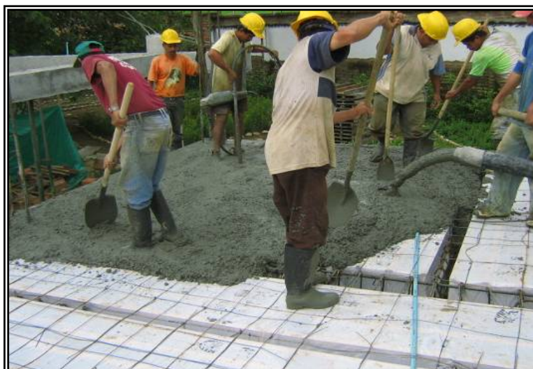
Figura 24. Concreto de planta
