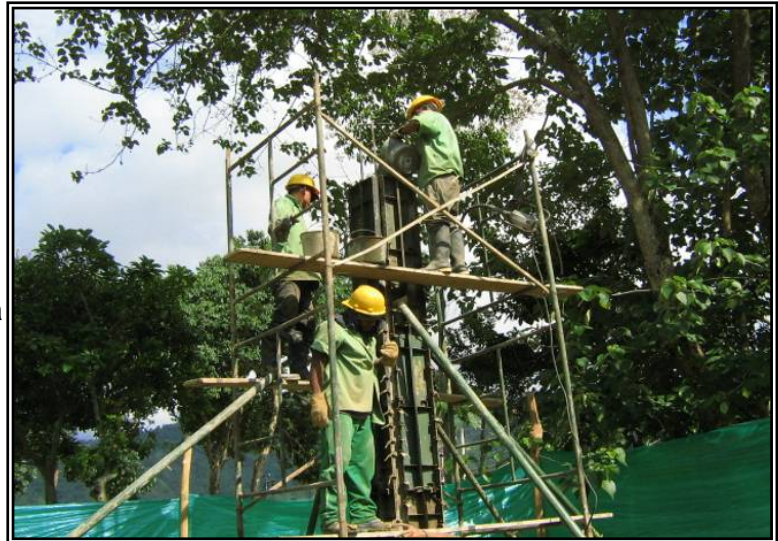
Figura 21. Cercha para maniobrar en alturas
