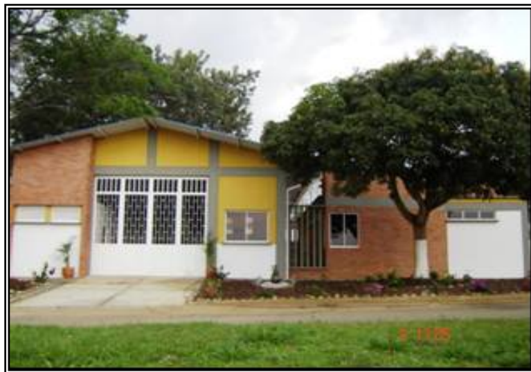
Figura 51: Cerramiento del pasillo que comunica las dos estructuras
