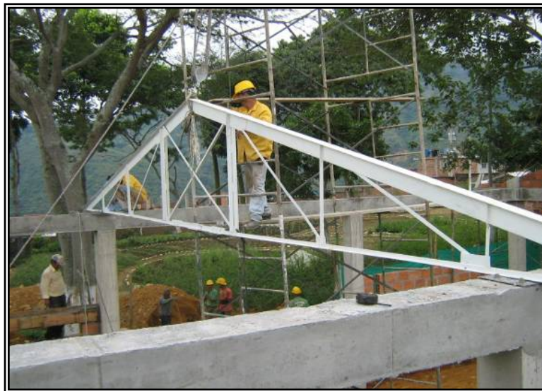
Figura 37: Instalación de cercha metálica reutilizada
