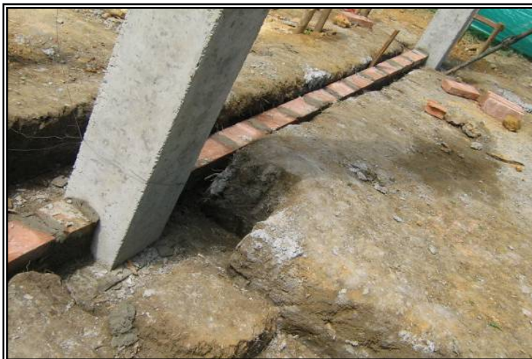
Figura 49: Sobrecimiento en la planta piloto
