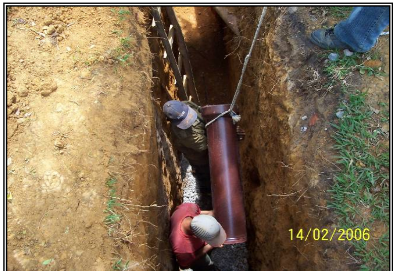
Figura 22. Instalación de tubería de gres
