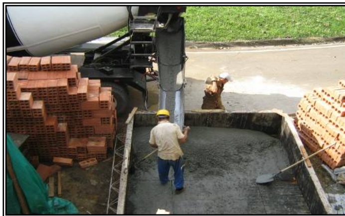
Figura 18. Control fundida concreto de planta.
