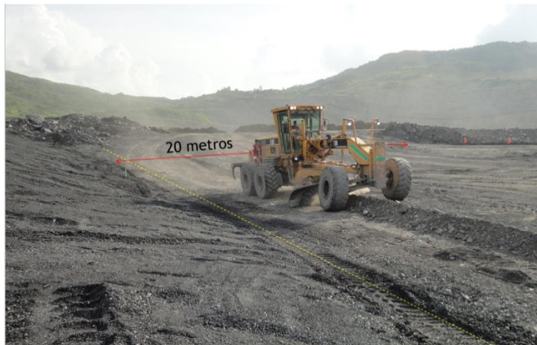
Figura 26. Estandarización de área de apilamiento con motoniveladora.
