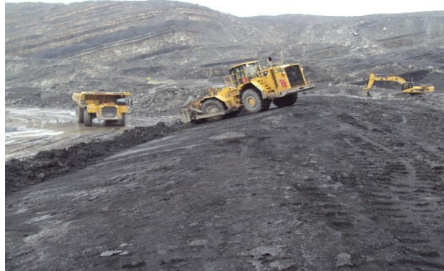
Figura 25. Limpieza de manto de carbón con tractor de llanta
