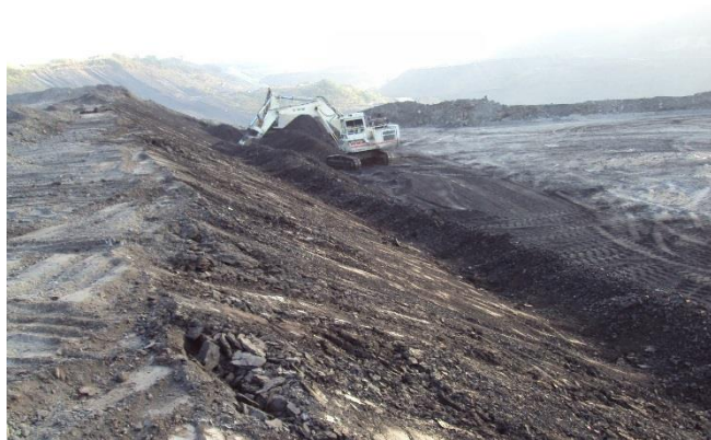
Figura 27. Apilamiento de carbón en la pata del manto
