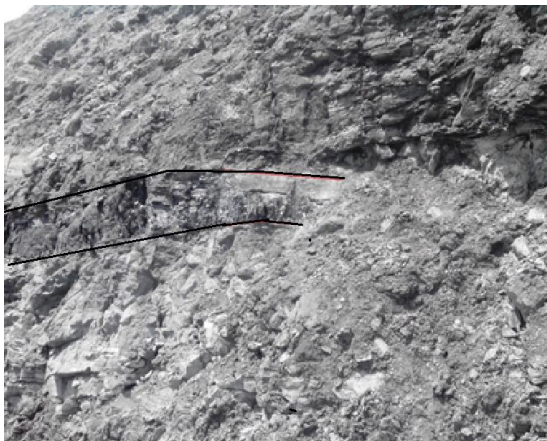
Figura 16. Pinchamiento de manto 00, zona de falla.
