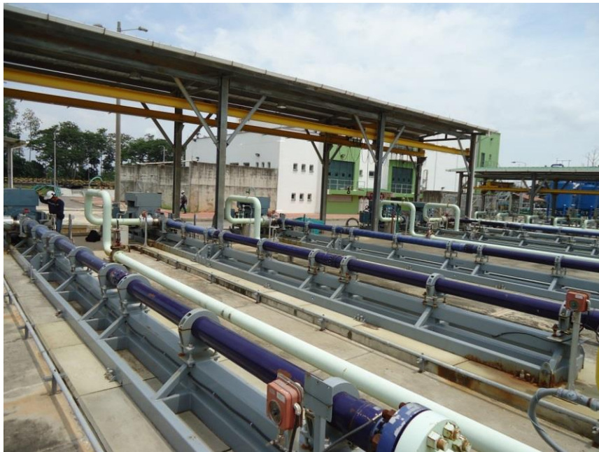
Figura 1. Bombas multietapa para inyección de agua en Yariguí-Cantagallo.
