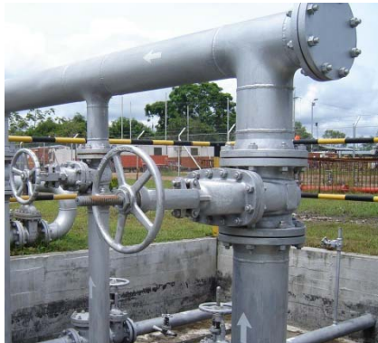
Figura 30. Válvulas de compuerta a nivel externo e interno
