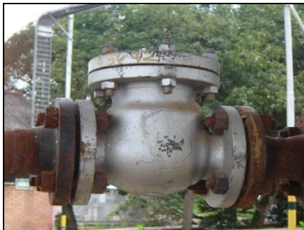
Figura 31. Válvulas cheque
