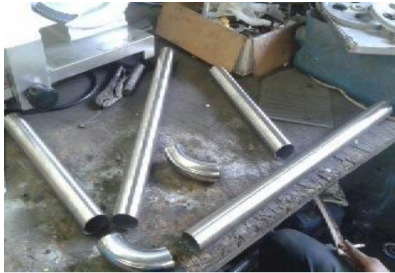
Figura 71. Piezas cortadas para la estructura
