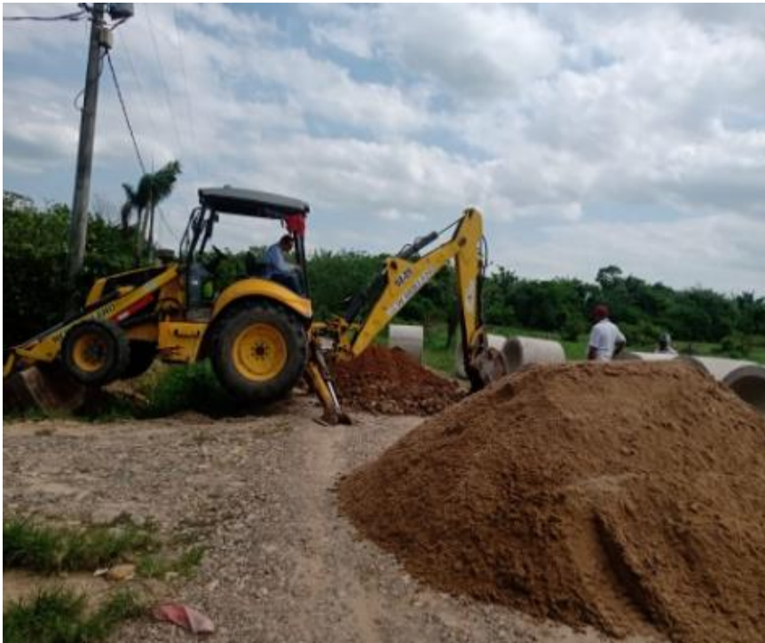
Figura 5. Arreglo de alcantarillado, Chita - Boyacá.
