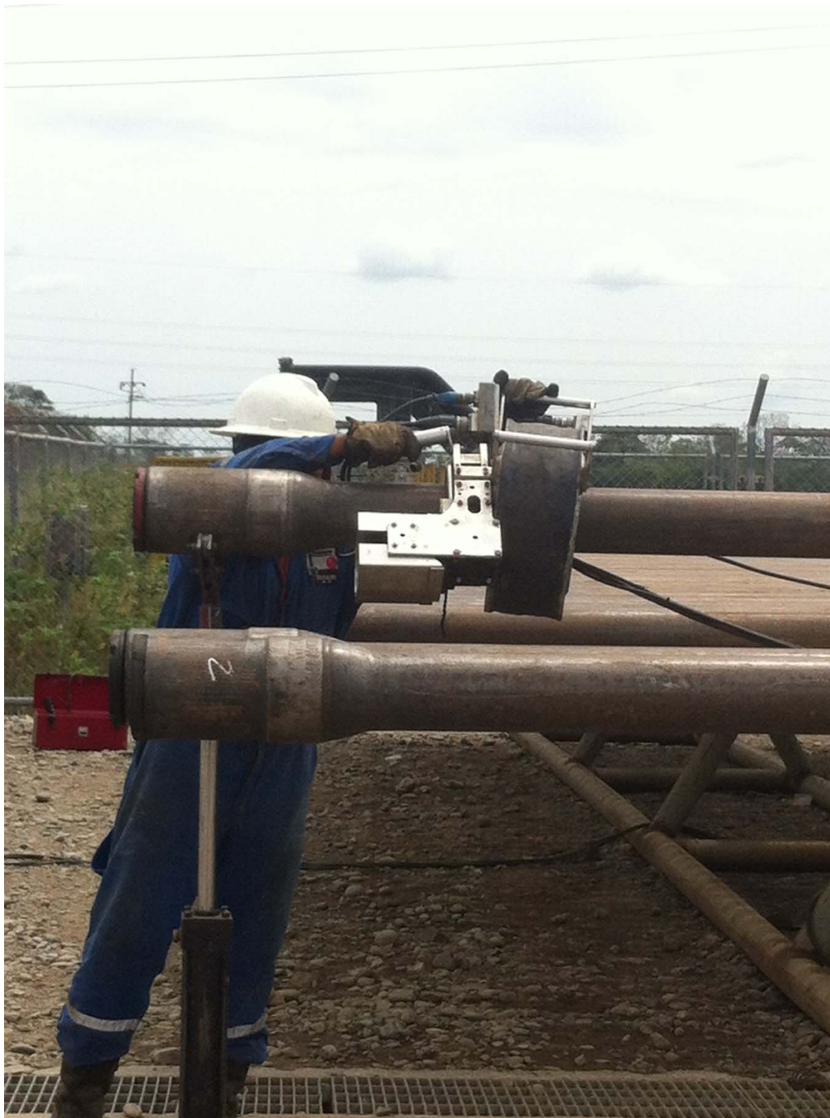
Foto 9 Inspección de tubería Nivel 5 con ultrasonido Campo Castilla-Pozo28
