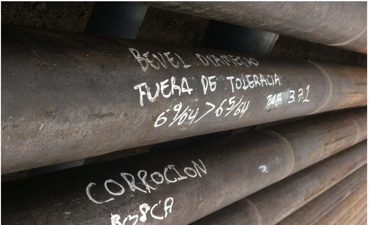
Foto 6 Inspección de tubería Nivel 3 Campo Castilla-Pozo28
