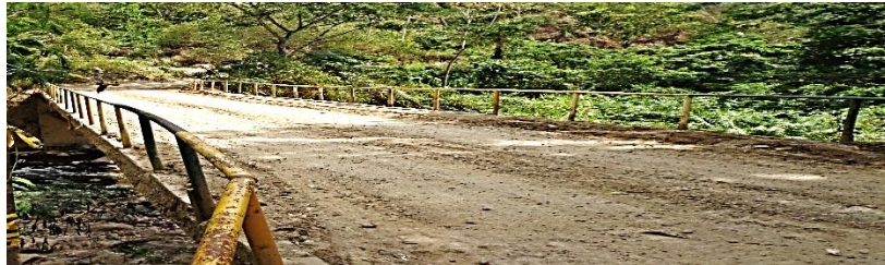
Figura 8. Puente El Ramo: (a) Paso superior, (b) vista costado y (c) vista inferior.
