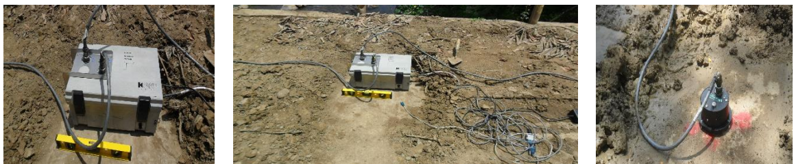
Figura 16. Registro fotográfico medición de vibración ambiental puente El Ramo.
