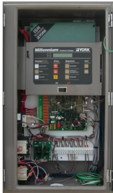
Figura 58. Caja de control integrado del chiller
