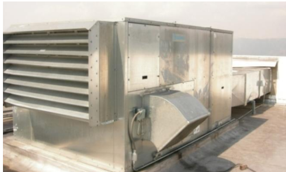
Figura 21. Unidades recuperadoras de energía
