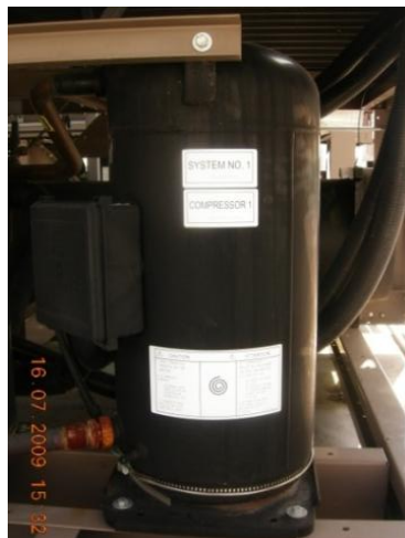
Figura 5. Compresor Hermético Copeland
