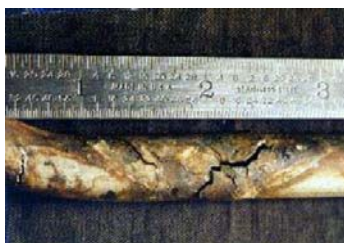
Figura 23. Agrietamiento externo en tubería de 304SS de servicio de instrumentos, bajo aislamiento. 26
