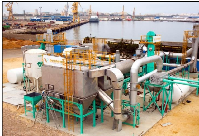
Figura 21. Desorción térmica.
