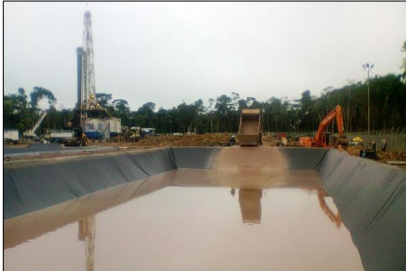
Figura 19. Confinamiento en piscinas y celdas.
