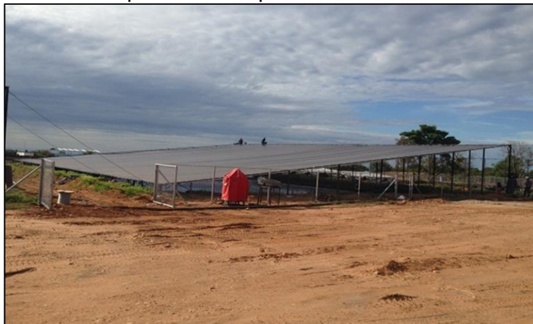
Figura 14. Fosas de disposición de rипios
