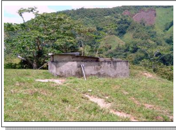
Figura 7. Tanque de almacenamiento del agua de captación
