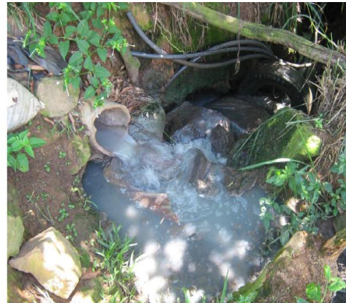
Figura 4. Descarga agua residual a la quebrada las burras.
