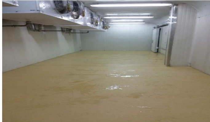
Figura 4. Estado final del piso
