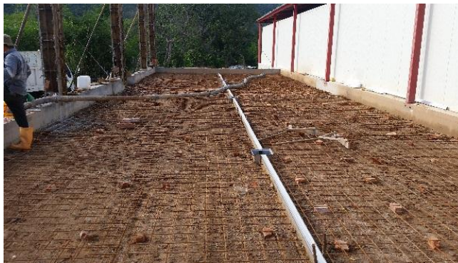
Figura 12. Placa de contra piso
