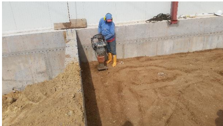
Figura 11. Relleno y compactación
