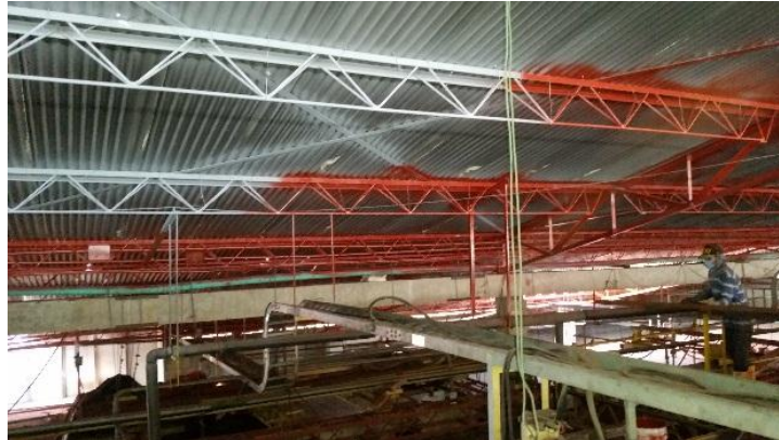
Figura 7. Aplicación de pintura epoxica
