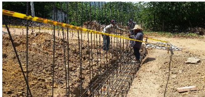
Figura 9. Armado del refuerzo
