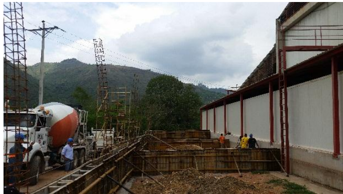
Figura 10. Fundida de muro
