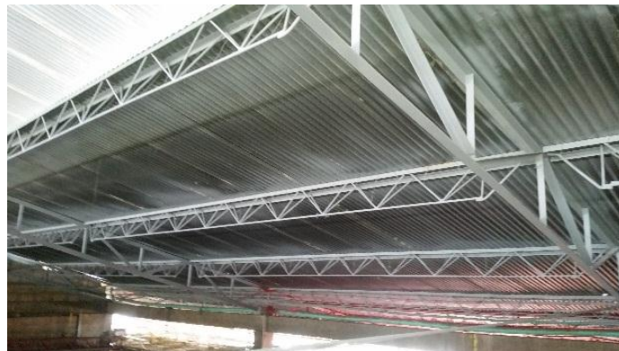
Figura 6. Aplicación de anticorrosivo
