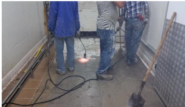
Figura 3. Preparación de la superficie
