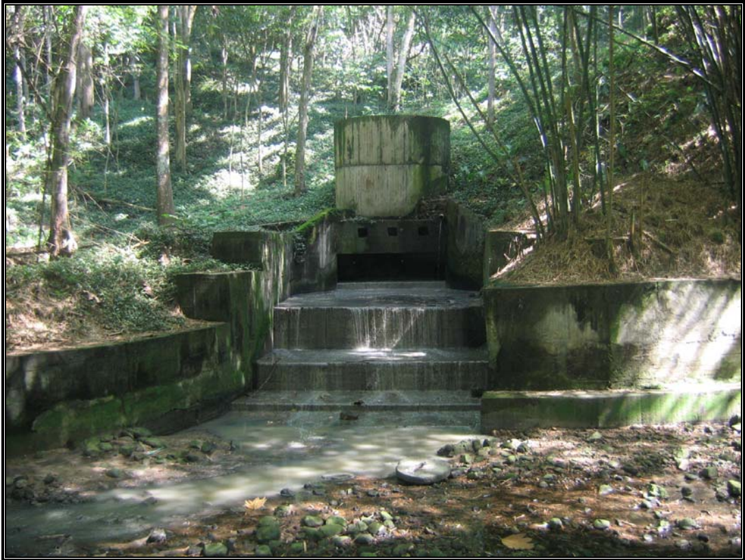
FIGURA 13 E-V San Miguel I Vortice Final y Canal de Entrega a Quebrada el Loro (Septiembre 2005)
