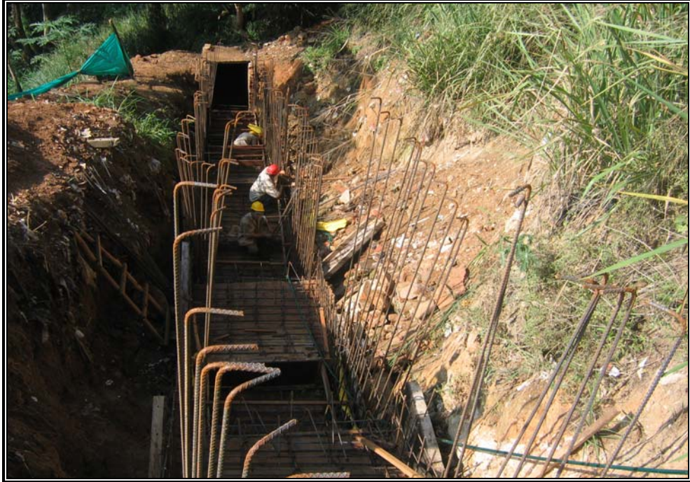
FIGURA 10 Remodelación Estructura de Vertimiento La Joya I (Noviembre 2005)
