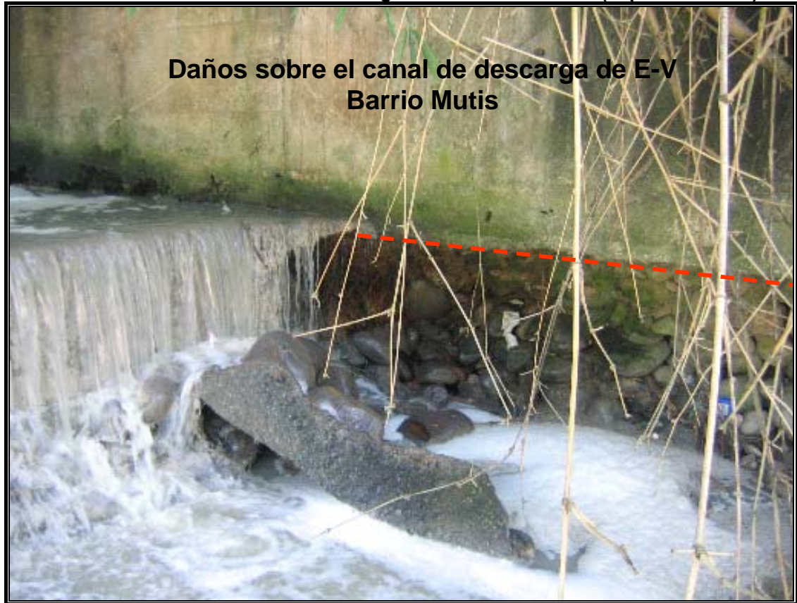
FIGURA 37 Daños en el Canal de Entrega de la E-V Barrio Mutis (Septiembre 2005)
