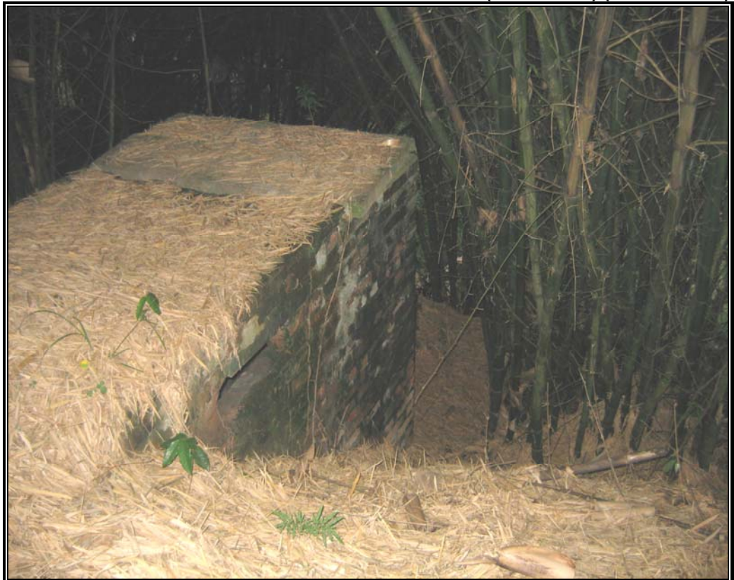
FIGURA 21 Estructura de Vertimiento La Puerta del Sol (Escalonada) (Octubre 2005)
