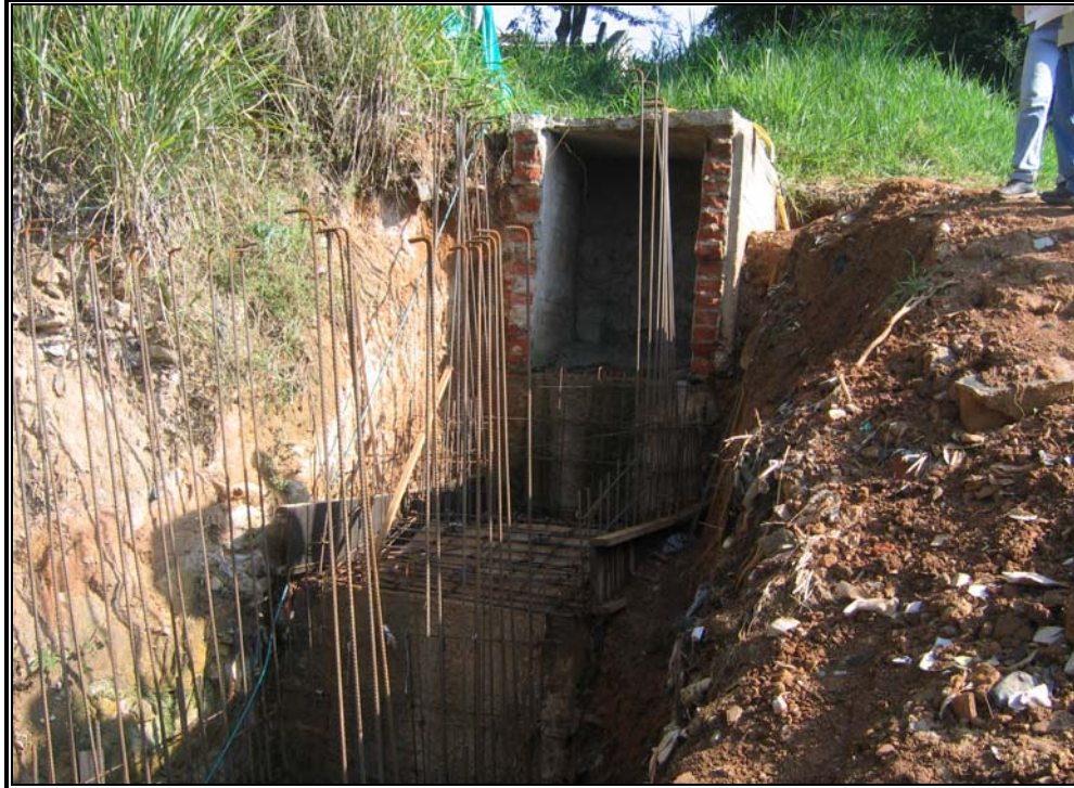
FIGURA 11 Antigua Estructura Joya I (Mampostería Confinada) (Noviembre 2005)
