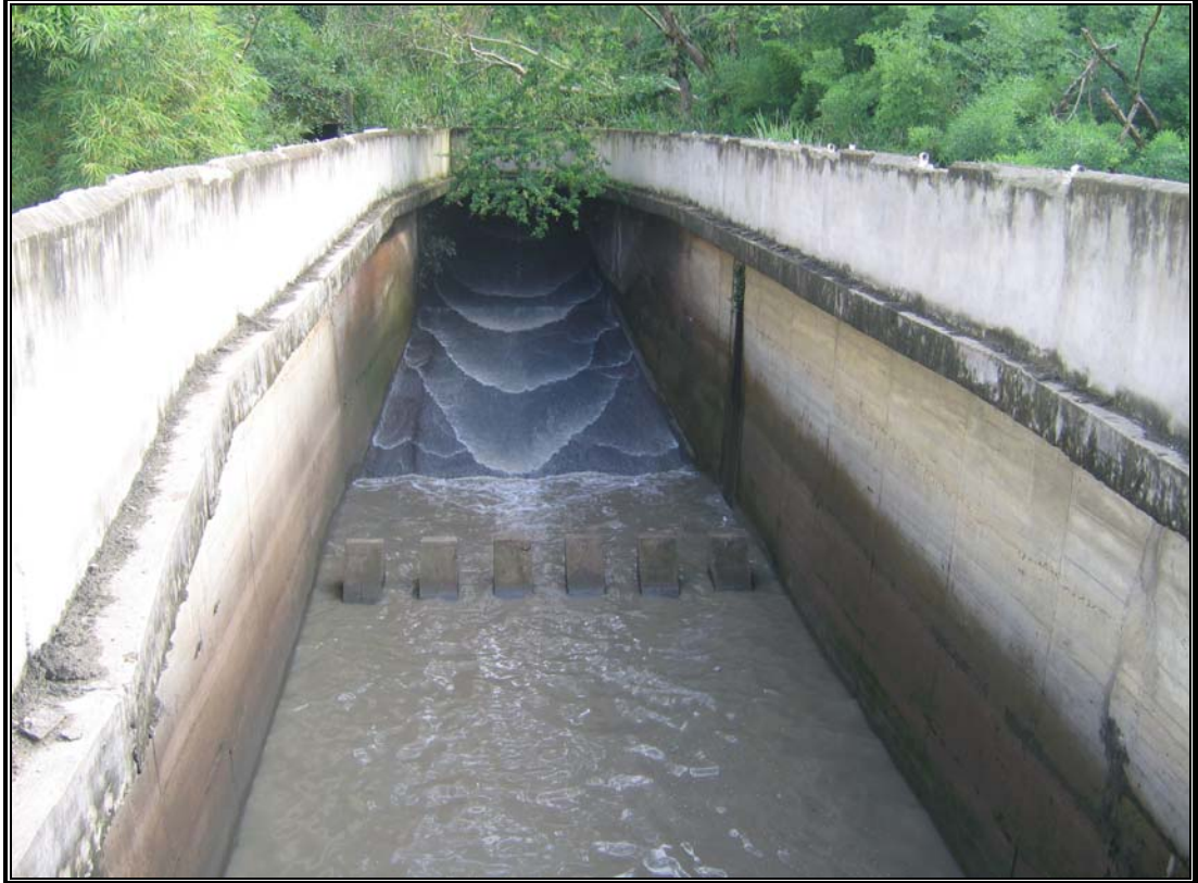
FIGURA 4 Estructura de Vertimiento Calle Sexta (Estructura de Disipación) (Octubre 2005)
