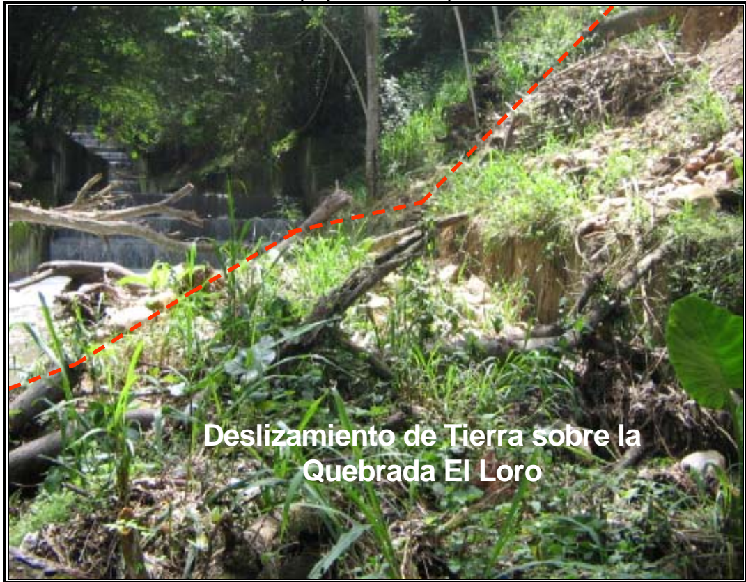
FIGURA 35 Deslizamiento de Tierra sobre la Canalización de la Quebrada el Loro (Septiembre 2005)
