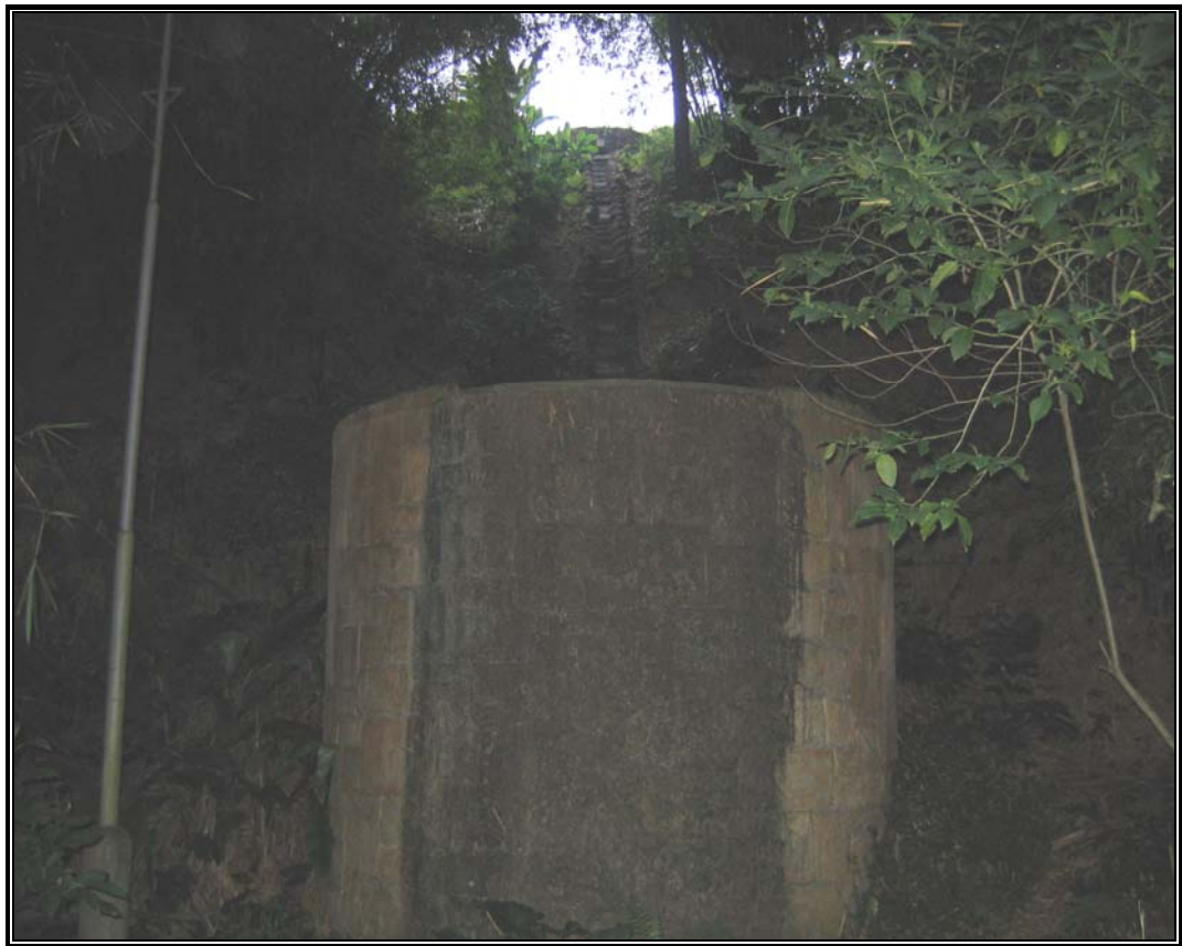
FIGURA 19 Vortice Final Estructura de Vertimiento La Presentación (Octubre 2005)
