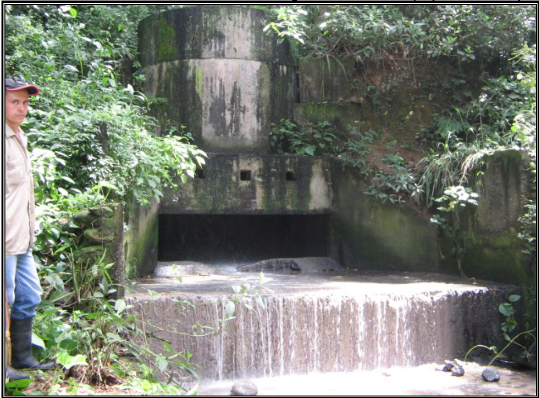
FIGURA 14 Estructura de Vertimiento San Miguel II Vortice Final (Septiembre 2005)
