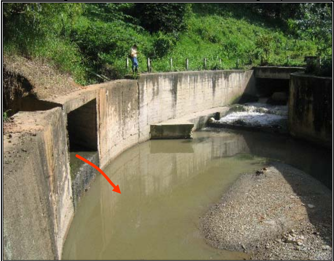
FIGURA 22 Entrega E-V La Salle a la Canalización de la Quebrada La Iglesia (Octubre 2005)
