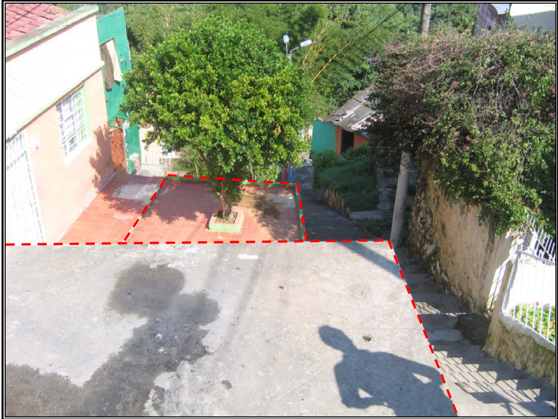
FIGURA 7 Estructura de Vertimiento Barrio Nariño (Estructura Escalonada) (Noviembre 2005)
