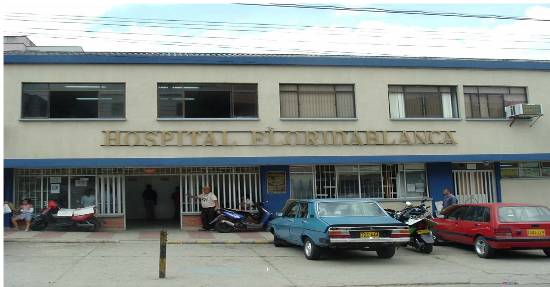
Figura 2. Ubicación actual del Hospital
