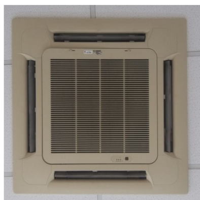
Unidad Interior (Evaporador)
