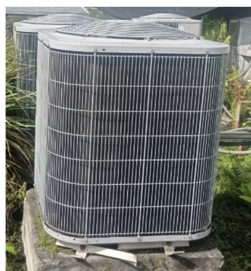
Unidad exterior (Condensador)
