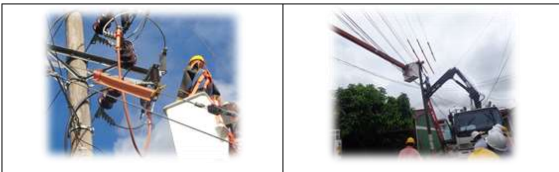
Figura 12. Mantenimiento de línea viva.
