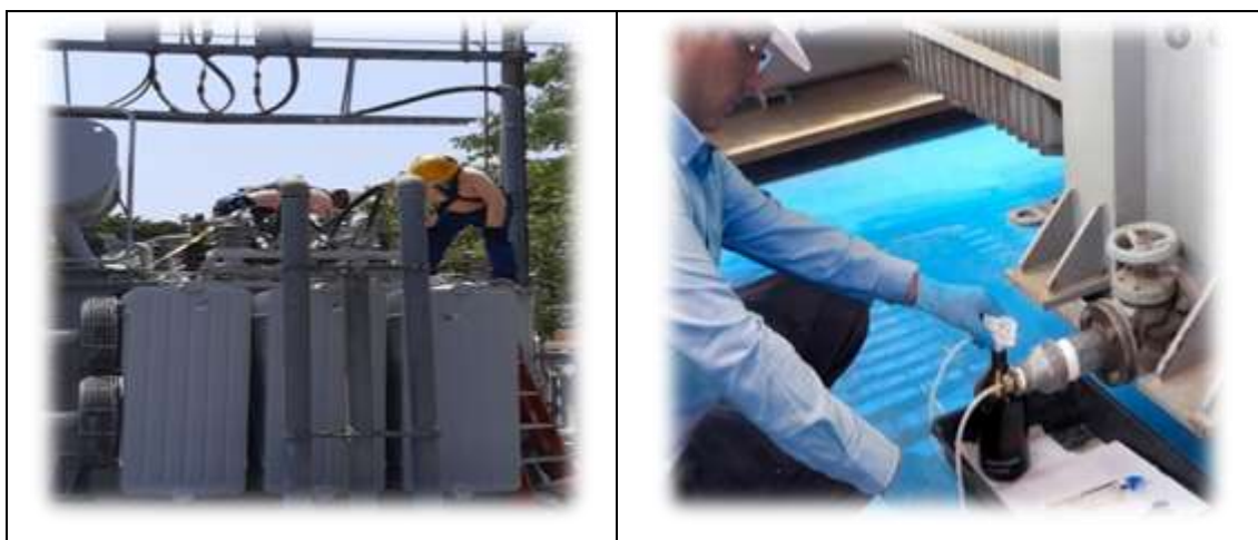
Figura 18. Trabajos de mantenimiento de SE.
