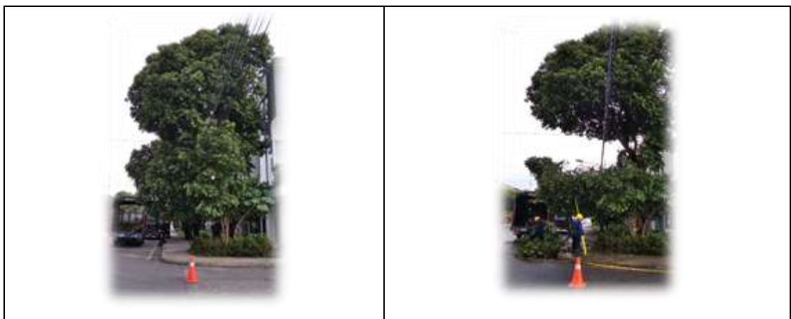
Figura 15. Trabajos de servidumbre SDL.
