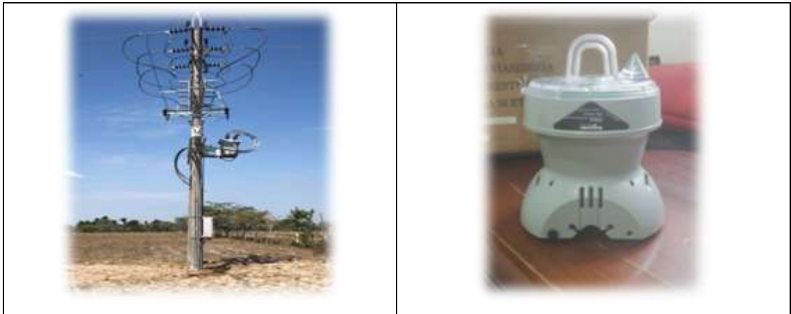
Fuente. Informe de gestión área técnica 2020 ENELAR ESP.
