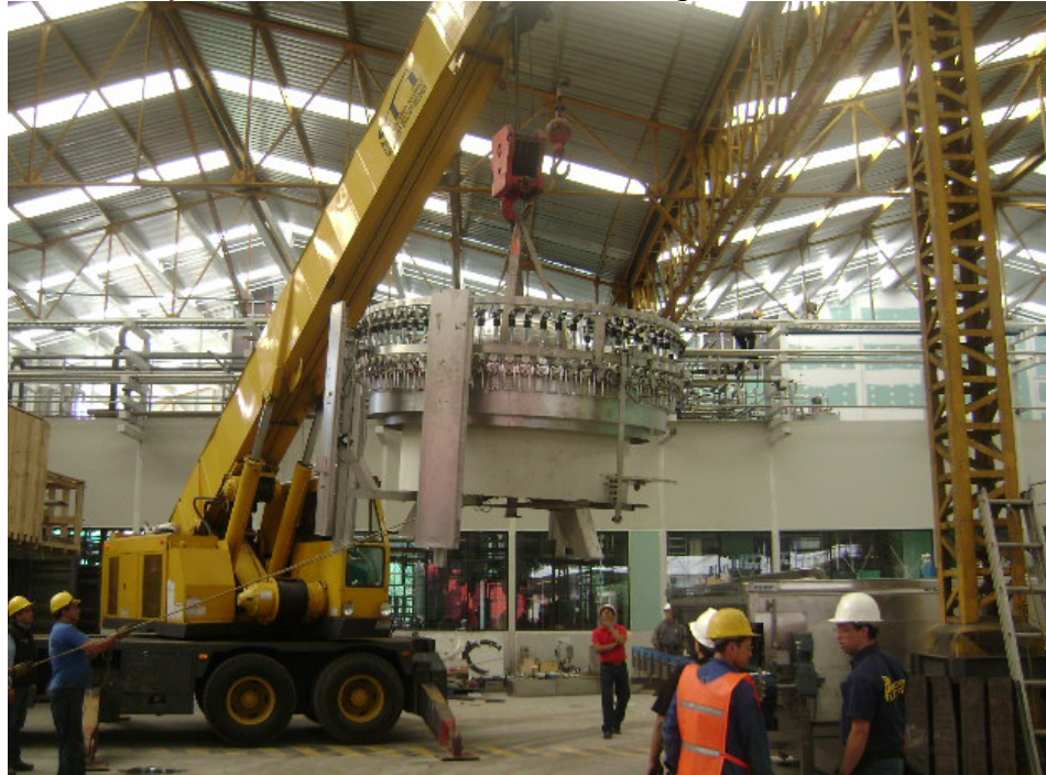
Figura 5. Montaje línea 9 “Hot fill” Coca-Cola Bogotá
