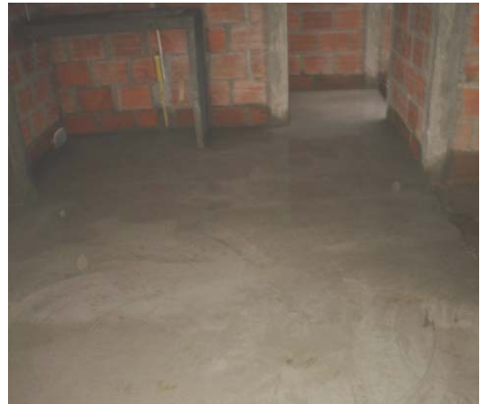
Foto 2. Piso acabado con llana metálica
