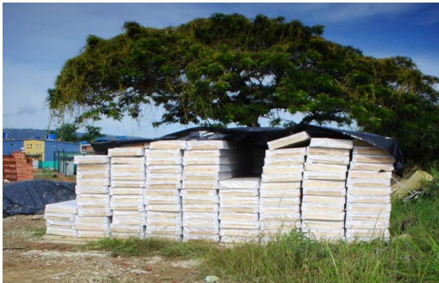
Figura 22. Protección del casetón de madera.
