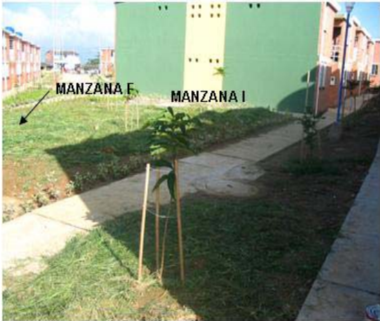
EMPRADIZACIÓN EN MANI FORRAJERO TERMINADA ( FRENTE A LA MANZANA F Y COSTADO DE LA MANZANA I)
