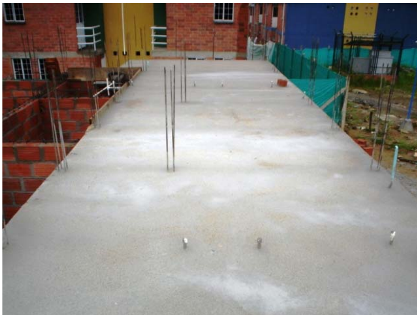
Figura 38. Acabado con llana metálica placa de entre piso.
