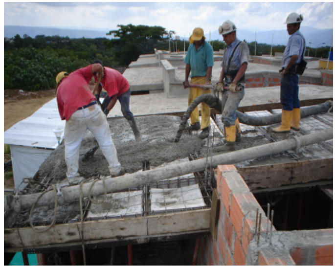
Foto 2. Fundición monolítica del gotero y la placa de cubierta
