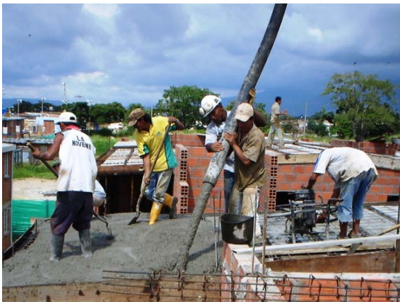
Foto 3. Vaciado del concreto (cubierta)
