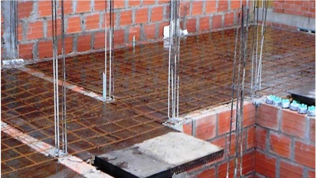
Figura 33. Detalle malla electrosoldada en placa de entre piso
