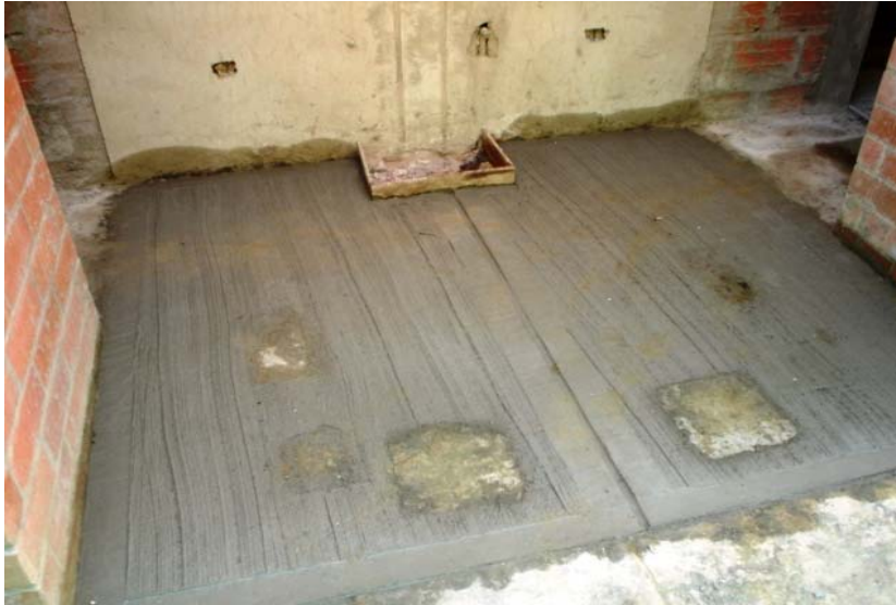
Figura 51. Piso de acceso terminado.
