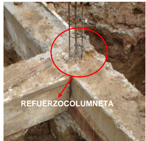
Figura 17. Foto 1 y Foto 2. Fundición vigas de cimentación.
