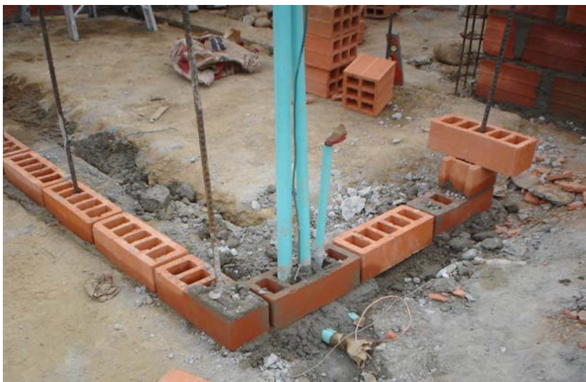
Figura 26. Tubería eléctrica en mampostería estructural.
