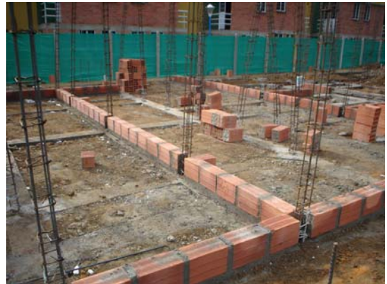
Foto 2: Primera hilada de ladrillos H-15.
