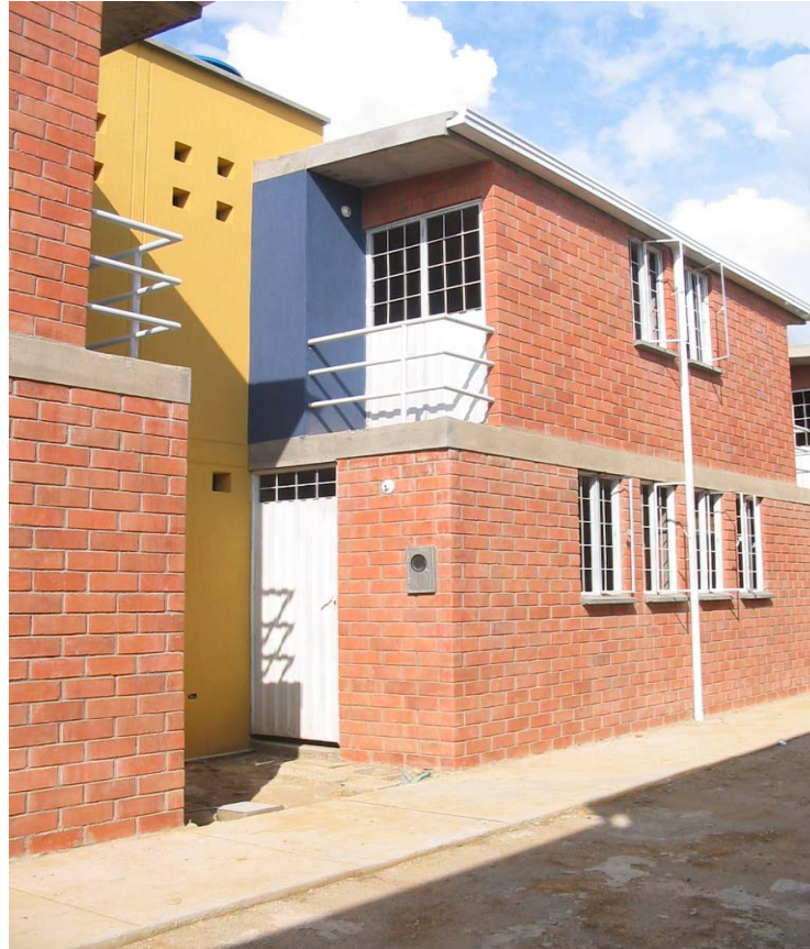
Figura 4. Fotografía fachada casas Proyecto Paseo la Feria.
