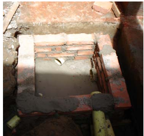
Foto 2: Construcción caja de inspección
