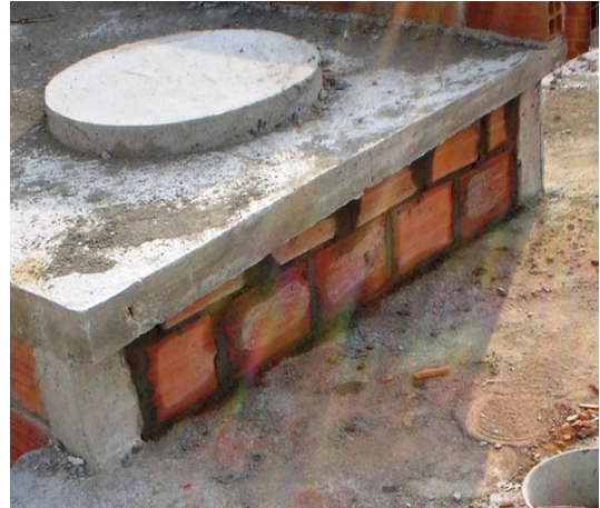
Foto 2. Detalle placa tanque y base circular del tanque elevado
