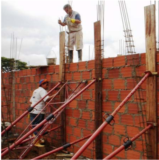
Foto 1: Se aprecia la formaleta y el vibrado hecho a las columnetas del primer piso.
