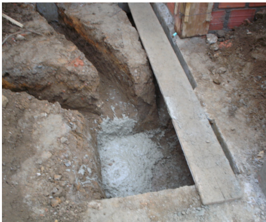
Foto 1. Excavación caja de inspección.
