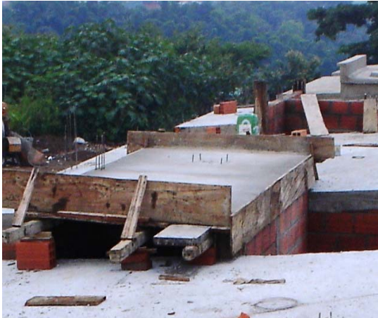
Foto 1. Construcción placa tanque
