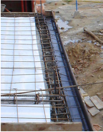
Foto 1. Armado del gotero de la placa de cubierta
