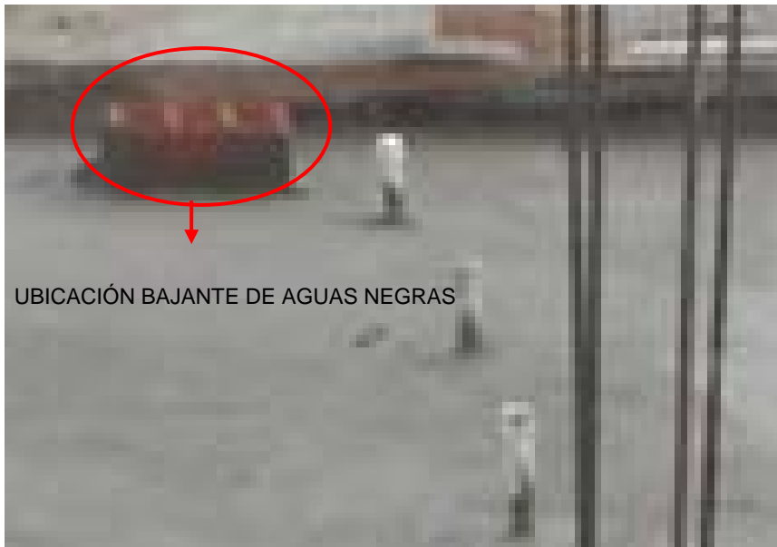
Figura 39. Puntos hidráulicos de baño, Lavamanos y ducha
