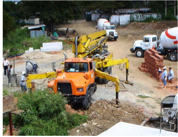
Foto 2. Maquinaria en obra para fundir placas de cubierta
