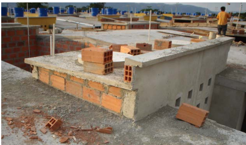
Figura 47. Construcción de alfajía.
