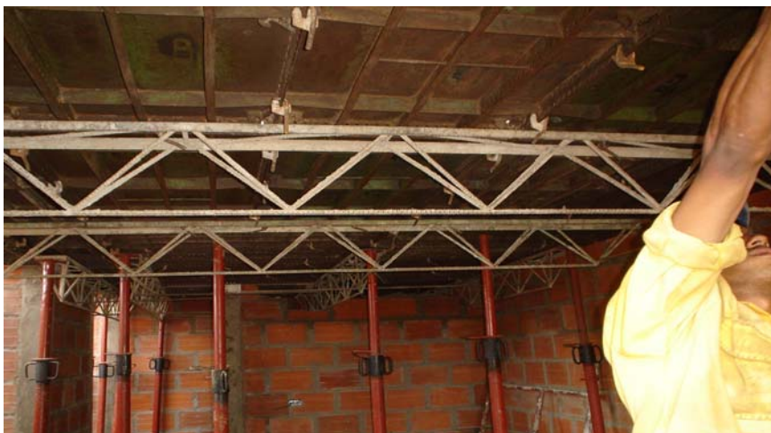
Figura 32. Formaleta metálica, vista desde abajo.
