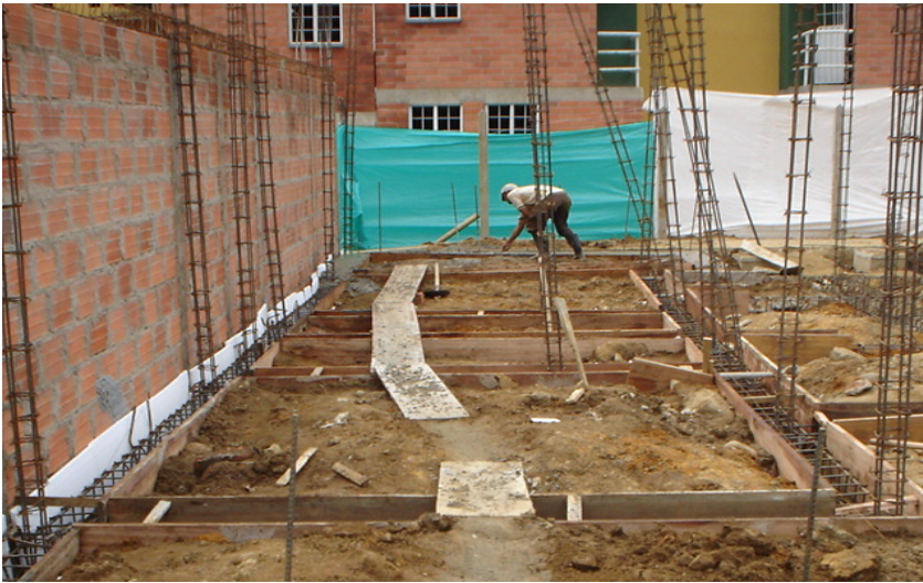
Figura 16. Refuerzo de vigas de cimentación y columnetas
