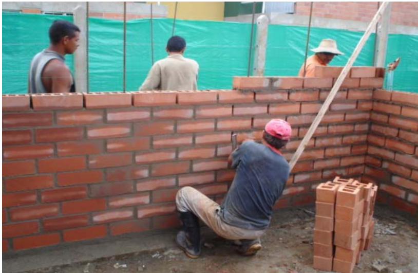
Figura 25. Construcción mampostería estructural.
