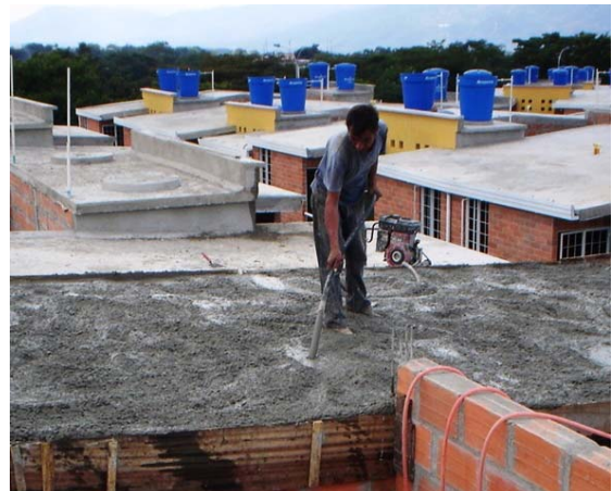
Foto 4. Vibrado del concreto (cubierta)
