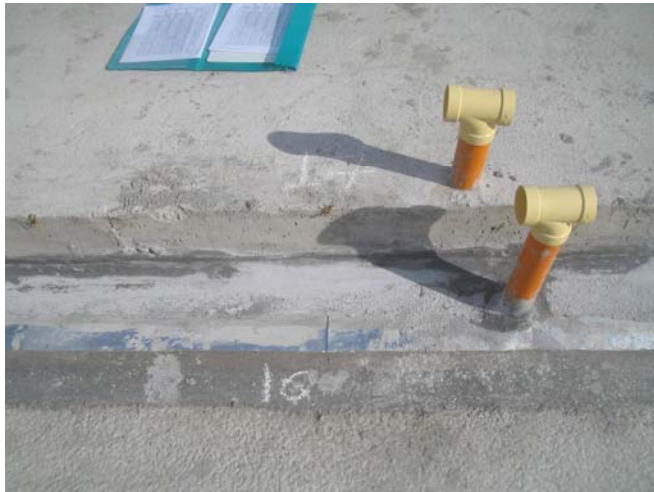
Figura 54. Flanche en lámina calibre 30.
