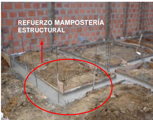
Figura 17. Foto 1 y Foto 2. Fundición vigas de cimentación.
