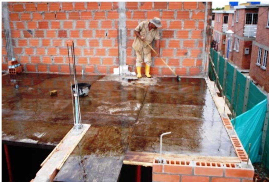
Figura 31. Formaleta metálica con aceite
