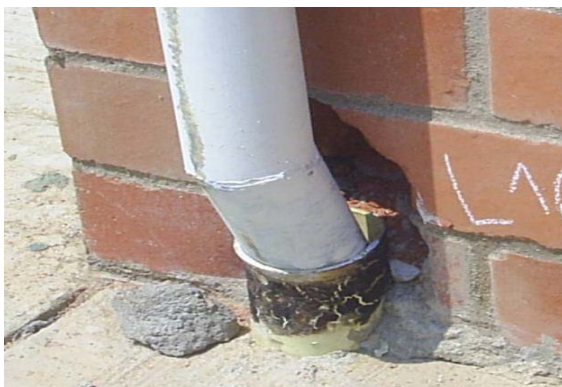
Figura 53. Empalme del bajante al niple.
