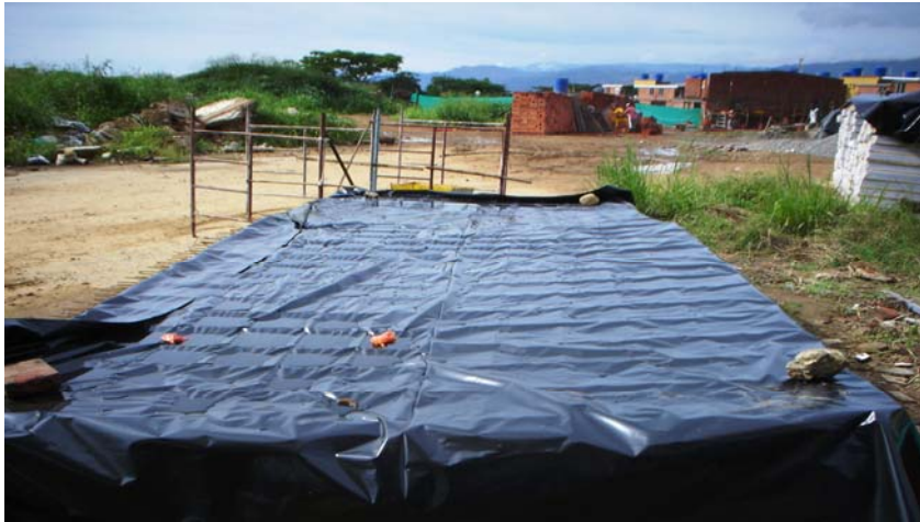
Figura 21. Protección malla electrosoldada.
