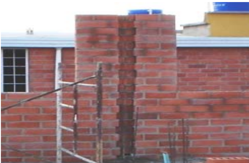
Figura 42. Columneta de amarre entre la mampostería estructural y la H-15.
