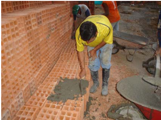
Foto 1: Relleno bloques H-15 con mortero 1:3
