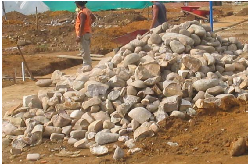
Figura 15. Se observa la piedra rajón utilizada en las pilas de concreto ciclópeo.
