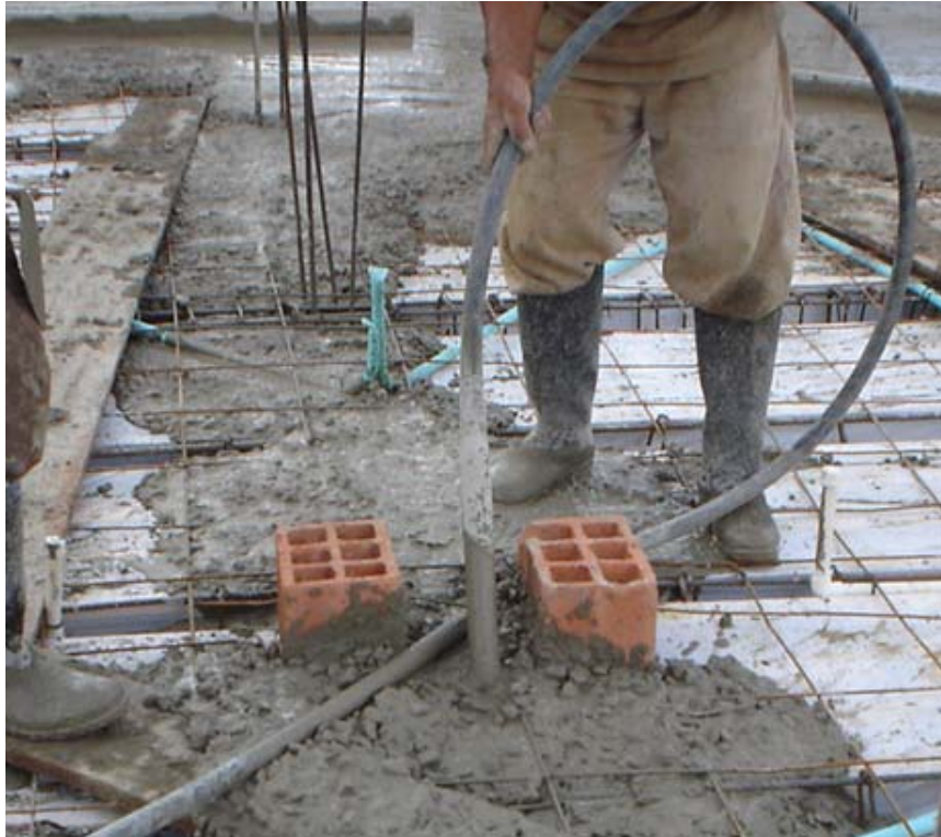
Figura 37. Vibrado del concreto de 3000 psi
