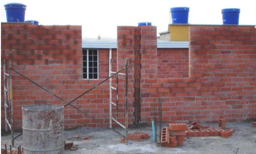
Figura 41. Construcción muro de fachada en ladrillo estructural.
