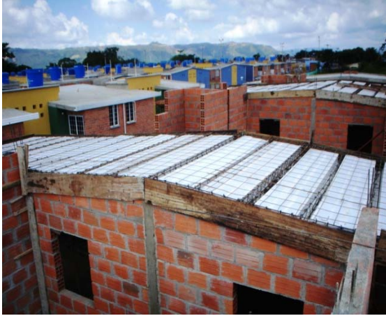
Foto 1. Placa aligerada (cubierta)
