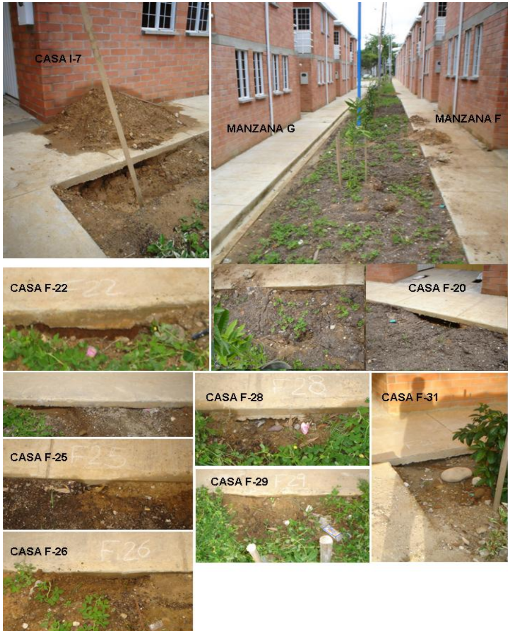
Figura 7. Registro fotográfico/ trabajos realizados por la empresa AMB en las obras de urbanismo/ fase II y III.
