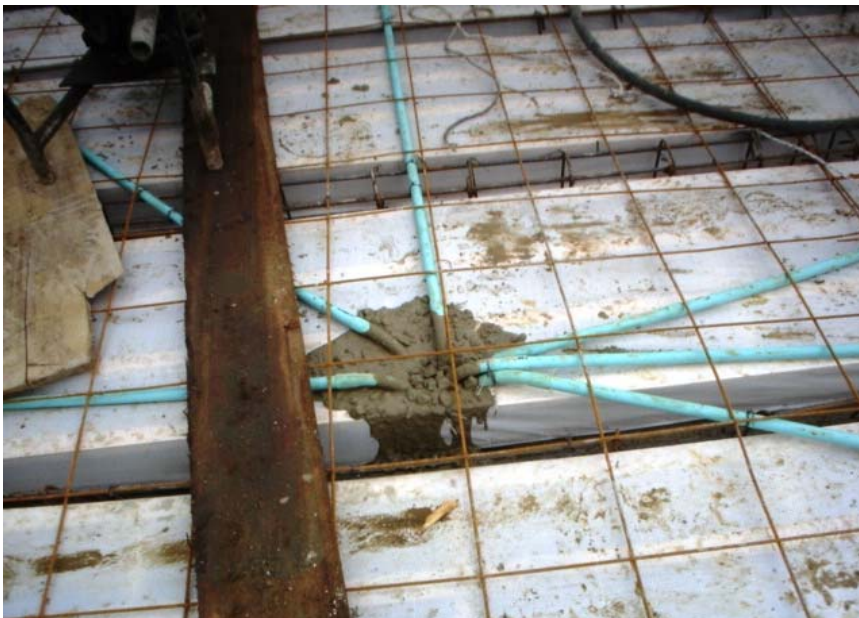
Figura 36. Detalle red eléctrica placa de entre piso
