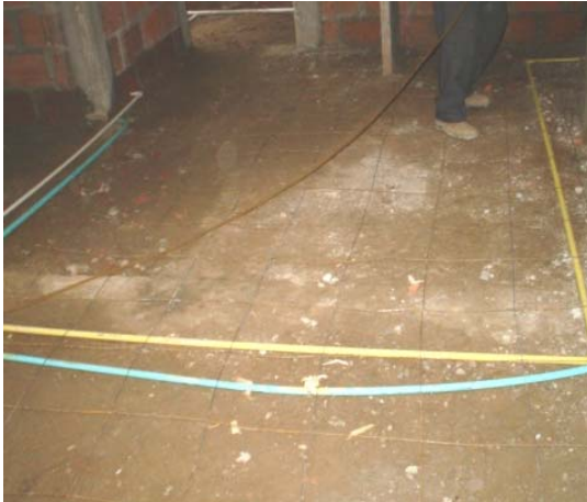
Foto 1. Tubería hidráulica, eléctrica, de gas y malla electro soldada
