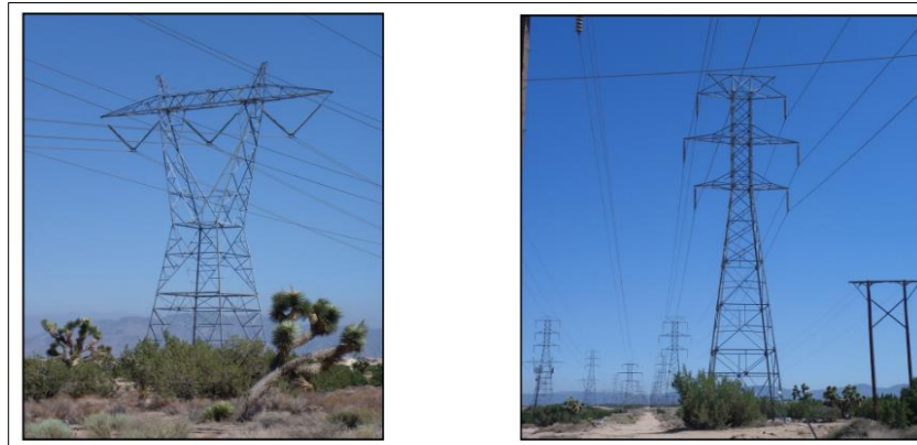
Figura 6. Líneas de transmisión de 500 kV y 230 kV de circuito sencillo y doble respectivamente. Adaptado de Kehang, (2019). Montar la estructura de la torre de acero de líneas de transmisión.
