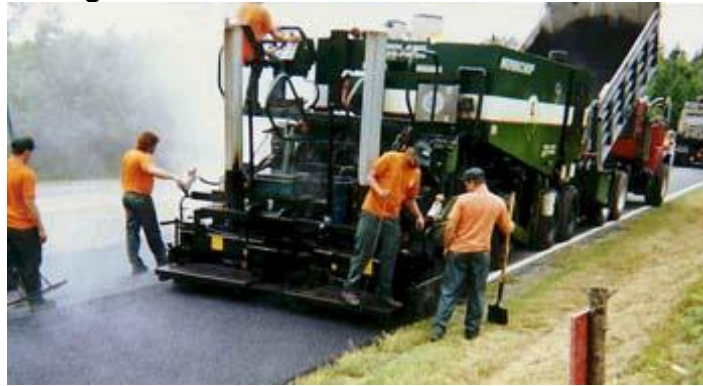
Fotografía 2-1. Colocación de la Mezcla en Obra.
