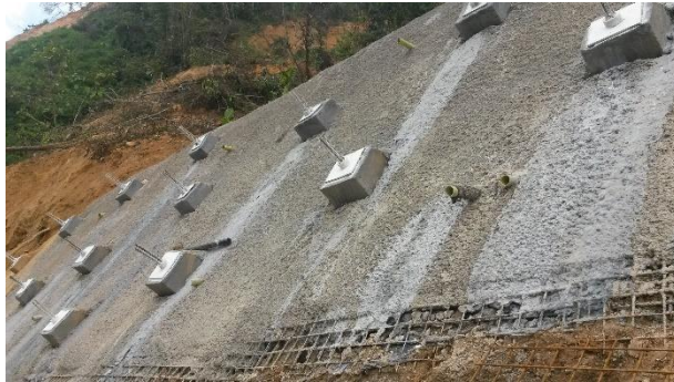
Figura 9. Estabilización de talud por medio de anclajes pasivos y subdrenes horizontales vía Bucaramanga-Cúcuta Km 15
