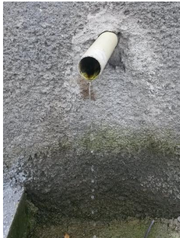
Figura 10. Subdren horizontal ubicado al pie del talud con flujo constante de agua vía Bucaramanga-Cúcuta Km 9
