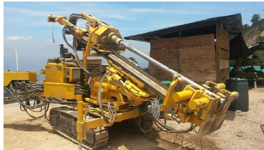
Figura 5. Equipo de perforación por rotopercusión con aire a presión.
