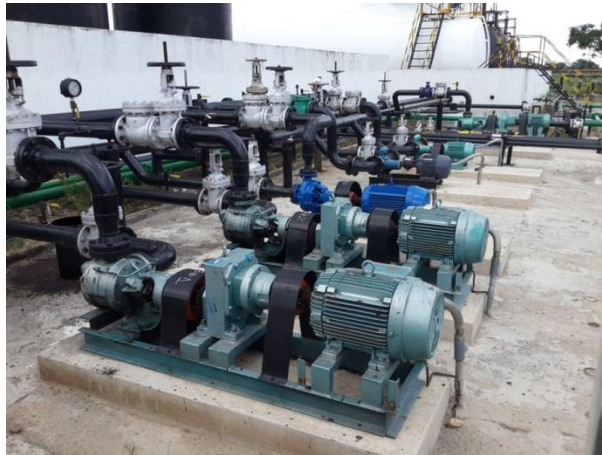
Figura 15: Área de bombas de crudo (Equipo Centrífugo de color azul rey).
