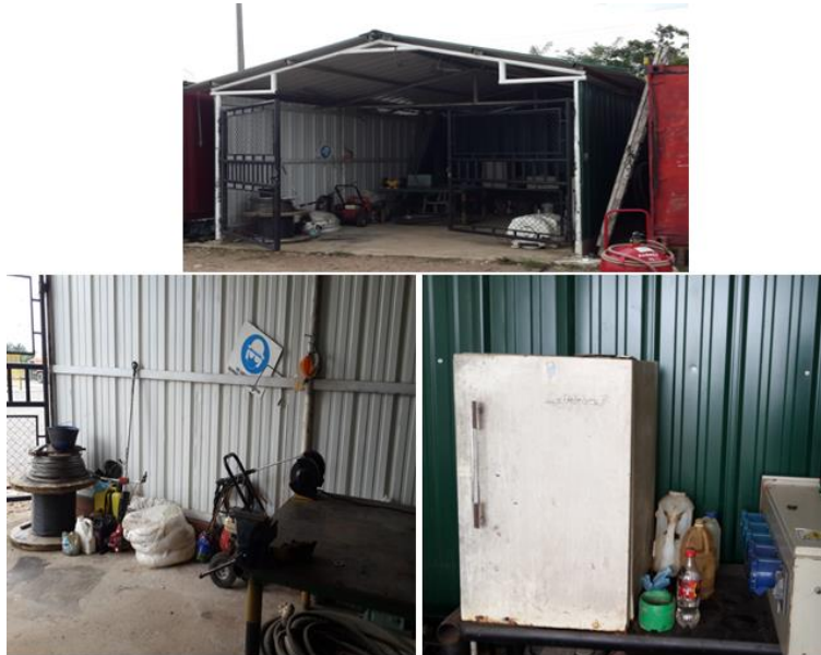
Figura 45: Estado actual de la bodega y el taller de mantenimiento.
