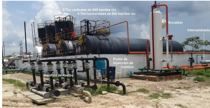
Figura 4: Panorámica de tanques de almacenamiento en Campo Tilodirán.
