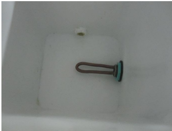
Figura 44. Montaje de la resistencia eléctrica de inmersión.
