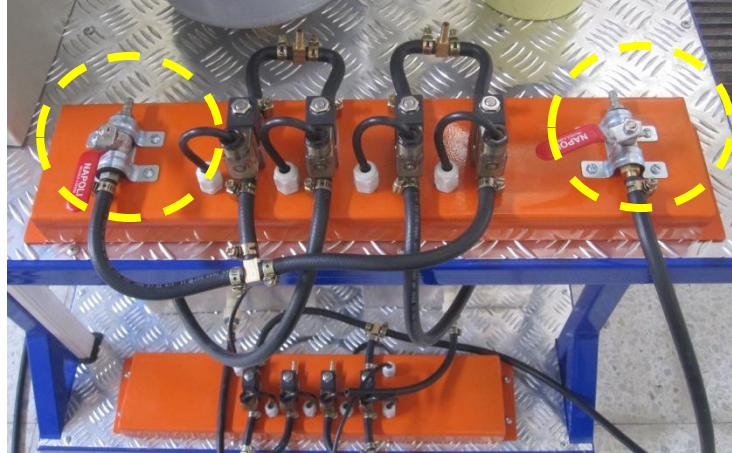
Figura 45. Montaje de las válvulas de suministro y drenaje.
