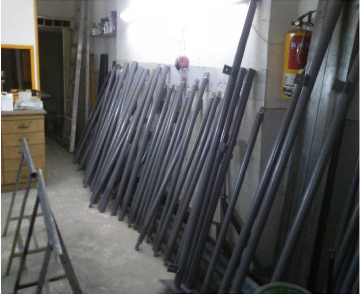
Figura 49. Pintura y terminado de la torre
