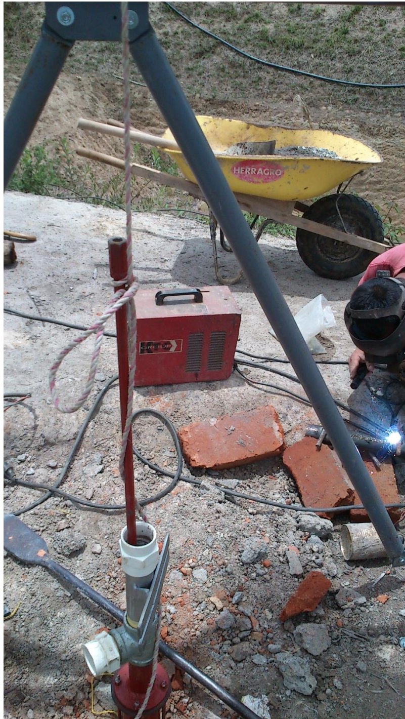
Figura 66. Instalación de la Bomba TOBO
