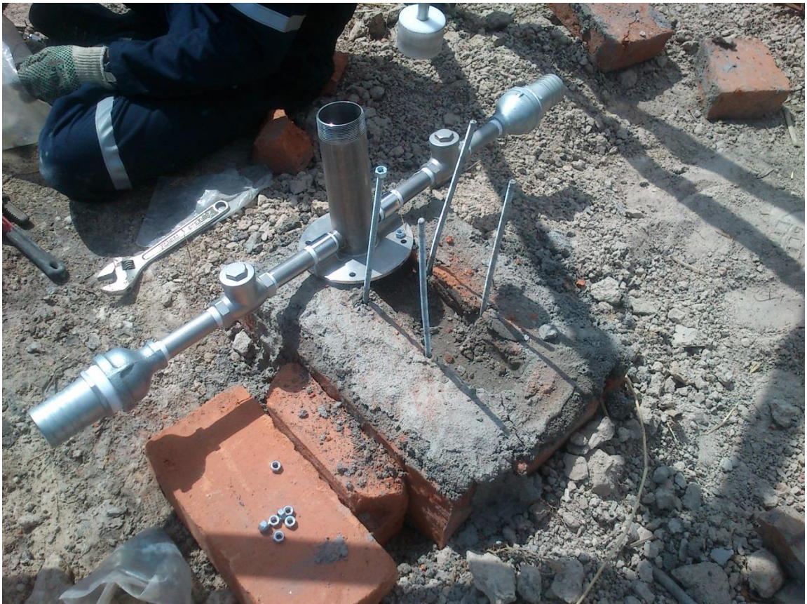
Figura 59. Instalación de la bomba
