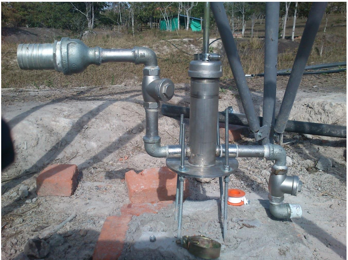
Figura 60. Instalación de la bomba 2
