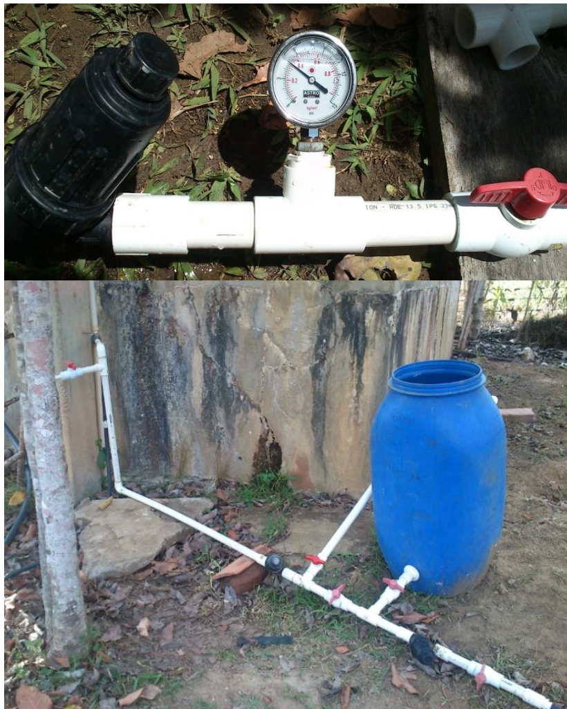
Figura 45. Prueba de presión de trabajo y montaje del cabezal de riego
