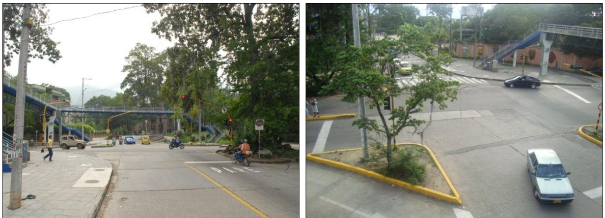
Ilustración 78. Registro Fotográfico Intersección Carretera Antigua – Calle 38
